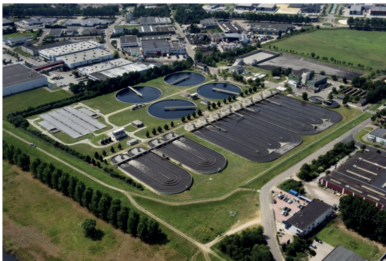
FIGUUR 2.2 LUCHTFOTO VAN RWZI VENLO, DE ANAEROBE TANK EN ANOXISCHE SELECTOR ZIJN AFGEDEKT, DE KLEINERE CARROUSELS ZIJN TRAP 1, DE GROTERE CARROUSELS ZIJN TRAP 2
