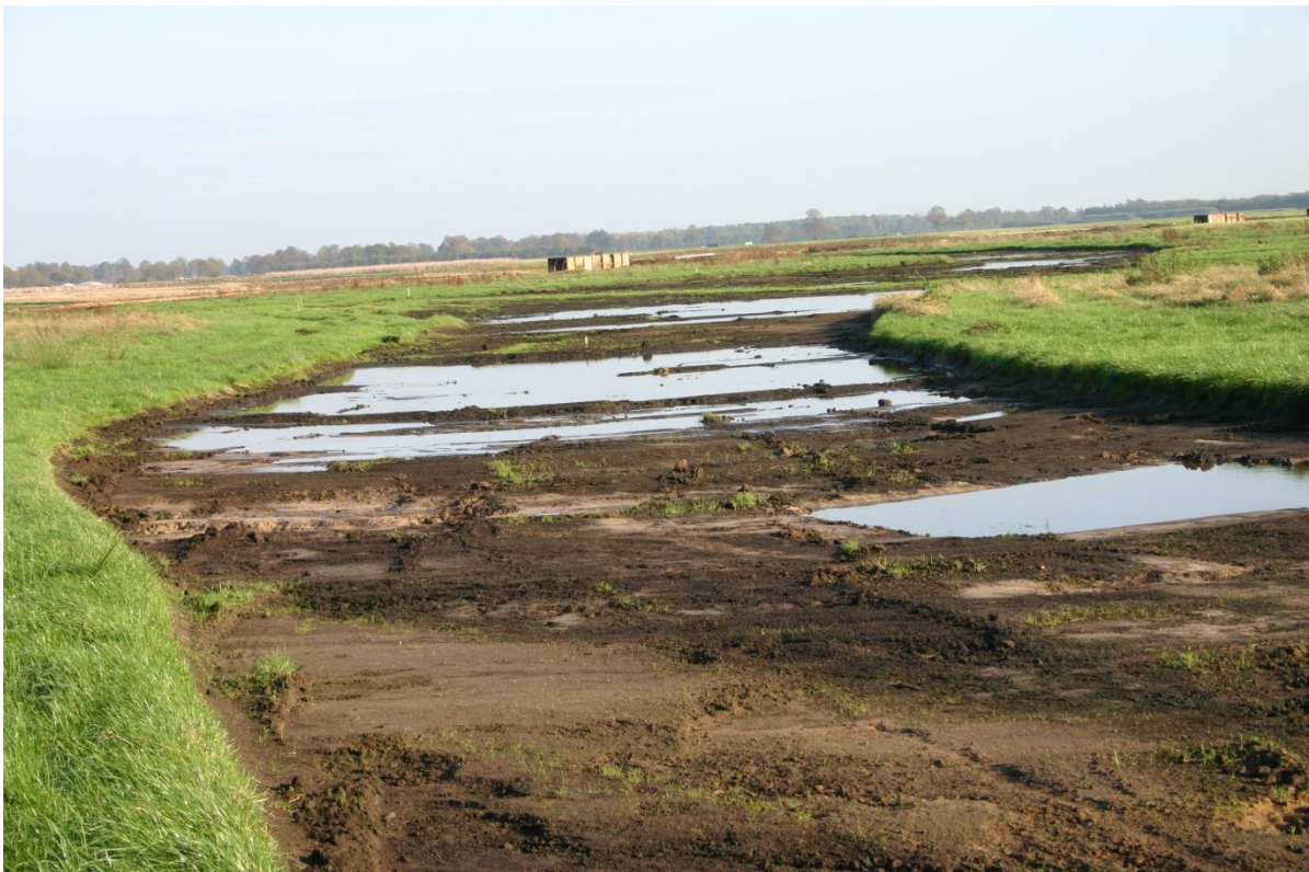
Foto 2.6: Herprofilering van de Geeserstream. Er is gekozen voor een laagte met als doel moerasontwikkeling te stimuleren (Foto: Piet Verdonschot).
