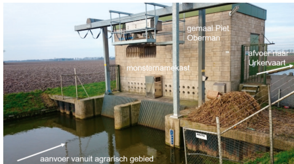
Figuur 5.3 Automatische monsternamekast bij gemaal Piet Oberman
