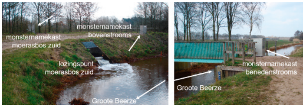
Figuur 3.8 Drie monsternamekasten rondom lozingspunt moerasbos zuid in Groote Beerze
