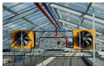
Warmte input via warmtewisselaars
