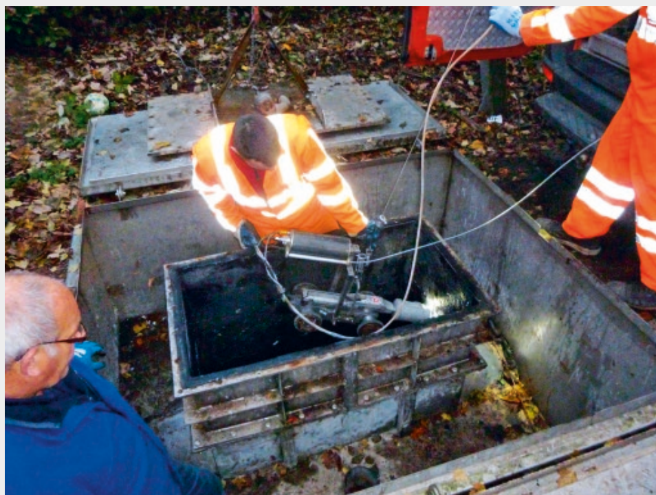
Figuur 4.18 Inbrengen inspectieapparatuur
