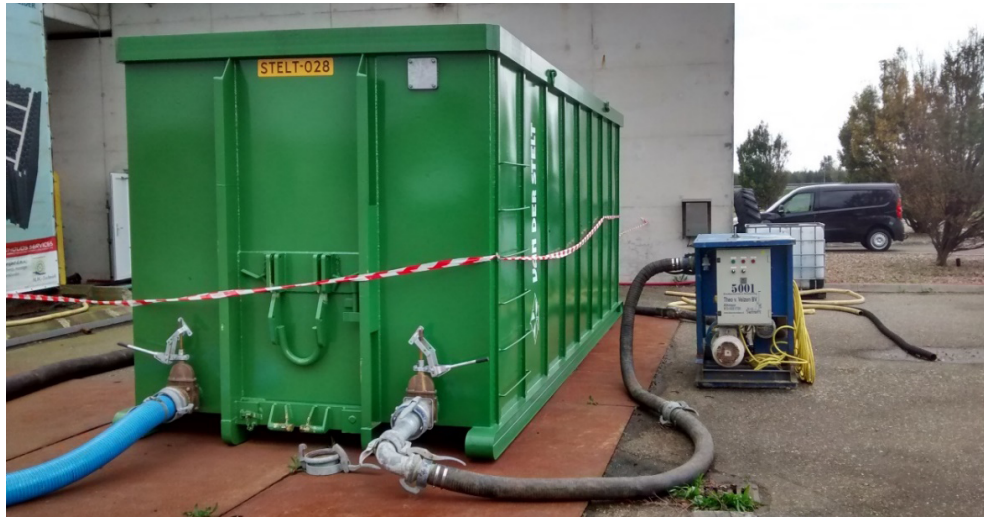
FIGUUR 4.11 GEMENGE CONTAINER VOOR VERGIST SLIB RWZI HAARMLEM-WAARDERPOLDER
