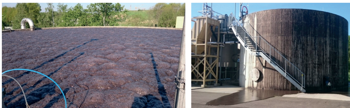
FIGUUR 9 PROBLEMEN MET SCHUIMVORMING DEMON INSTALLATIE LAND VAN CUIJK
