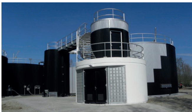
DEMON® INSTALLATIE RWZI NIEUWEGEIN
