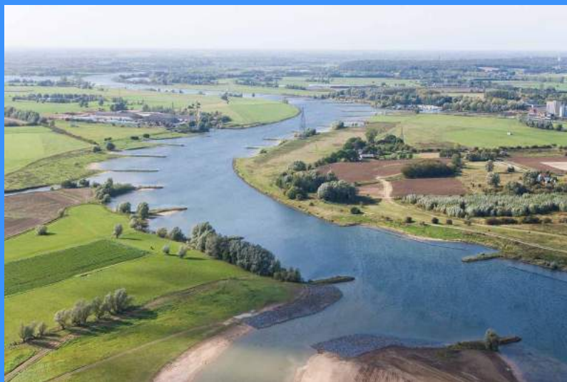
Luchtfoto van het voorland van de Grebbedijk (rechts op de foto).
