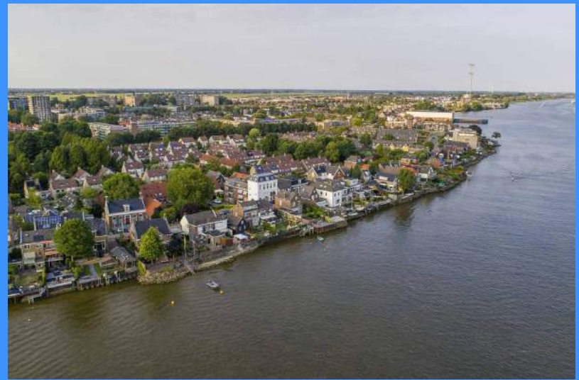
Hoogteopgave bij de rivierdijken in Sliedrecht. Een versterking van Rivierdijk-West is moeilijk inpasbaar binnen het huidige dijkprofiel [068] .
