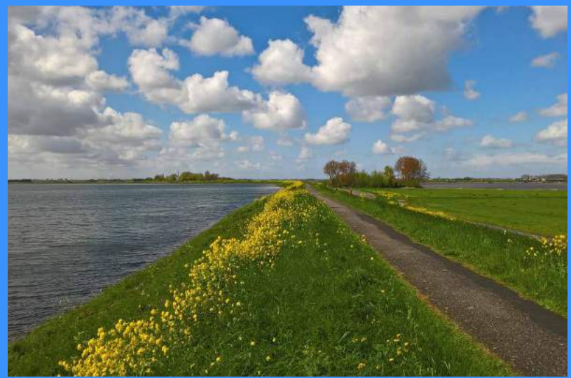
De huidige Markermeerdijk.
