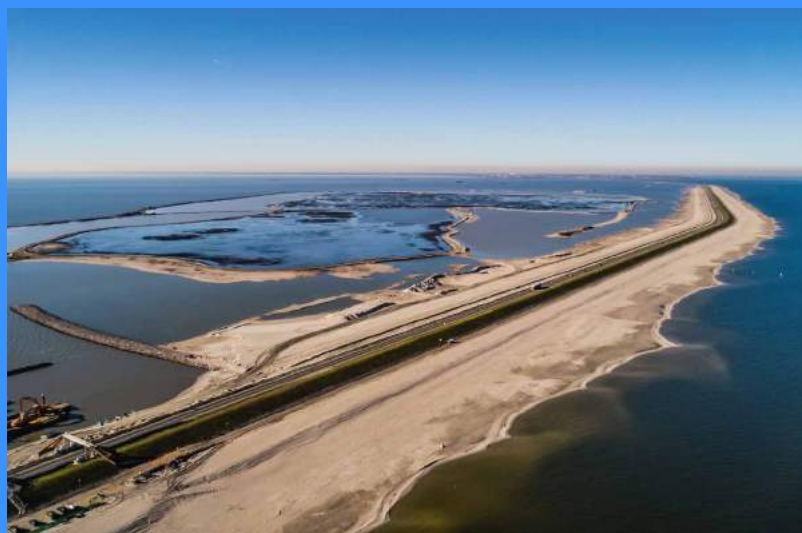
Zandige versterking Houtribdijk in aanbouw.
