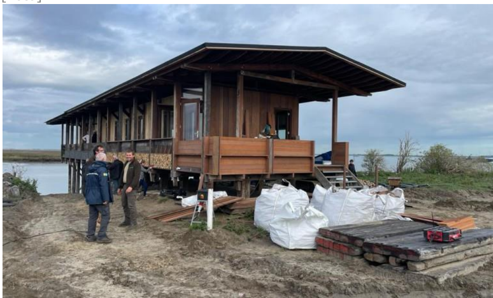
Het veldstation in aanbouw
