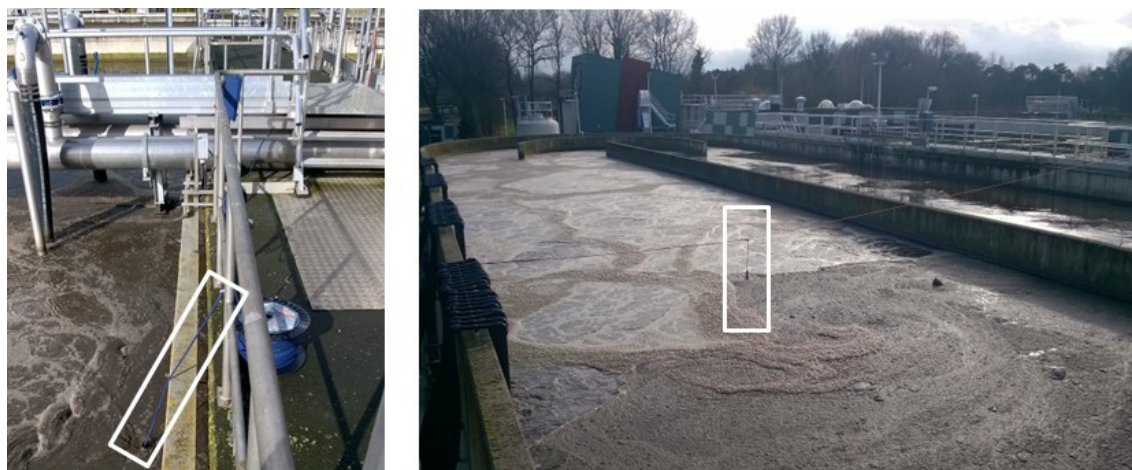
FIGUUR 3.1 INSTALLATIE LACHGASSENSOR IN LINKS NIEUWEGEIN IN STALEN PIJP EN RECHTS AAN EEN TOUW IN HET MIDDEN VAN HET BELUCHTINGSVELD IN SOERENDONK
