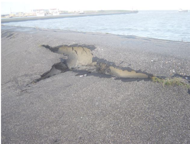
SCHEUR TEN GEVOLGE VAN ZETTING EN UITSCOELING
