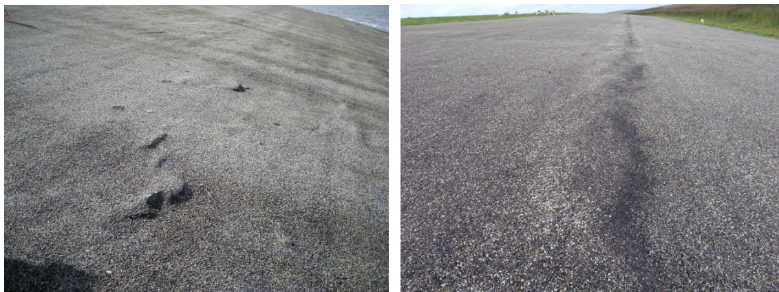
FIGUUR 9 LOKALE OPBOLLINGEN (LINKS) EN EEN LIJNVORMIGE OPBOLLING (RECHTS)
