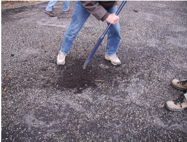
FIGUUR 19 CONTROLE VAN EEN OPBOLLING M.B.V. EEN STOOTIJZER
