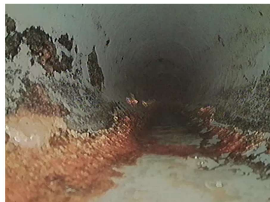
Figuur 4.15 Beeld klein stukje verder in horizontale leiding. Op de linker foto zijn losse brokken afzettingsmateriaal zichtbaar (kon met camera worden weggeduwd). Onduidelijk waardoor dit is gekomen. Op deze leiding en achterliggend deel heeft nog niet eerder een reiniging plaatsgevonden
