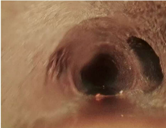
Figuur 4.57 Beeld met daarop de inpijkkende leiding (rechts) van appartementencomplex 1 (op circa 5 m in leiding vanaf inspectiepunt)
