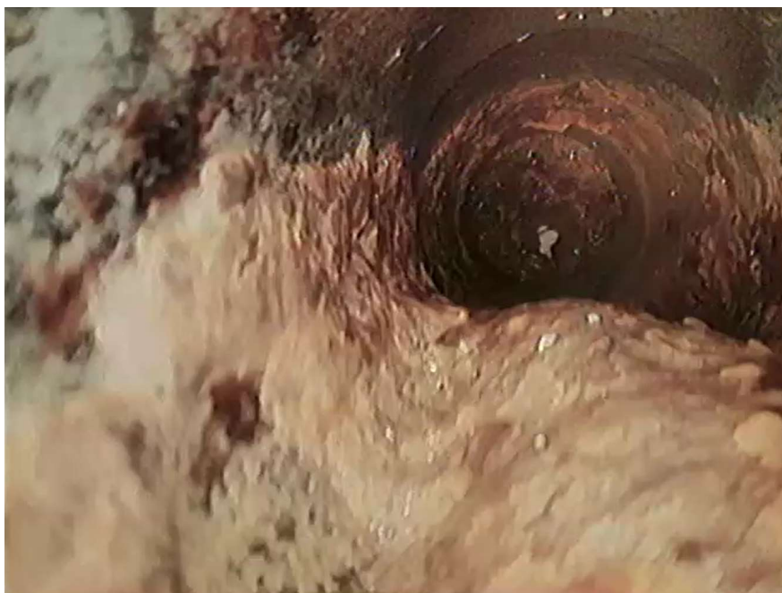
Figuur B3.6 Beeld net na zaagtand met op achtergrond ontstopningsstuk (flens) zichtbaar
