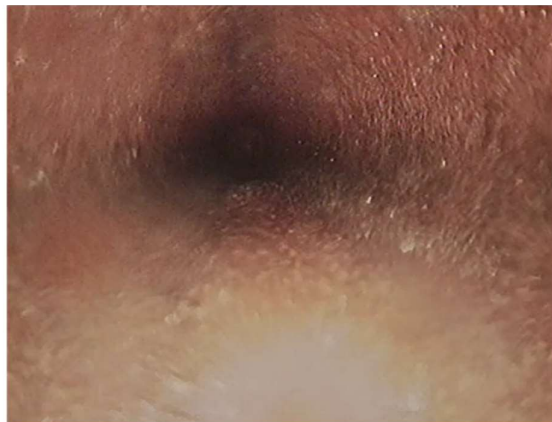
Figuur 4.22 Beeld na de betreffende afzetting op voorgaande foto. Hoge druk spuit kon hier niet komen en dit deel is dus niet gereinigd
