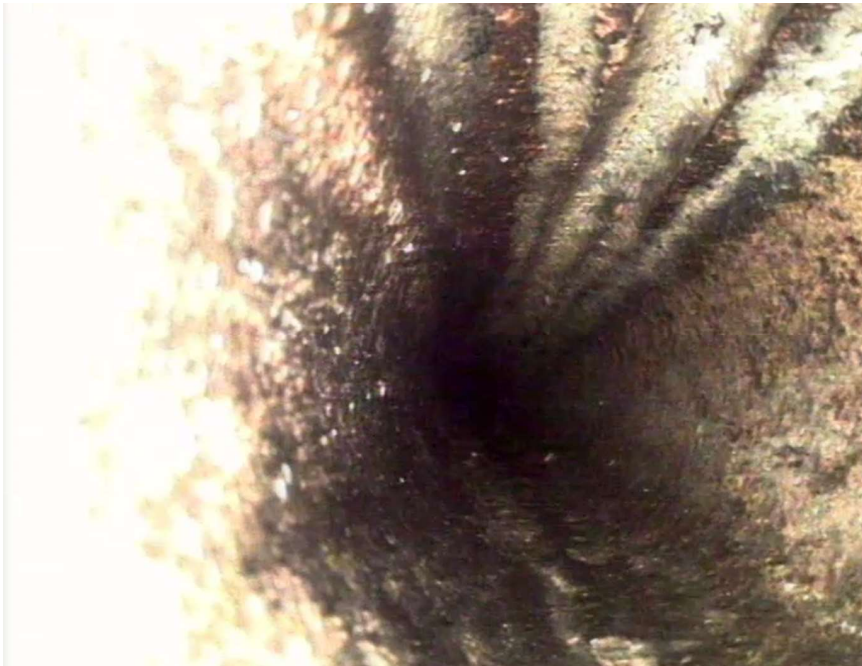
Figuur B2.3 Beeld direct na bocht. Verticale leiding richting kruipruimte
