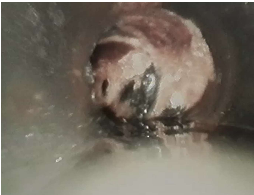
Figuur B1.38 Vlak voor bocht. Het losse stuk afzetting is weggespoten
