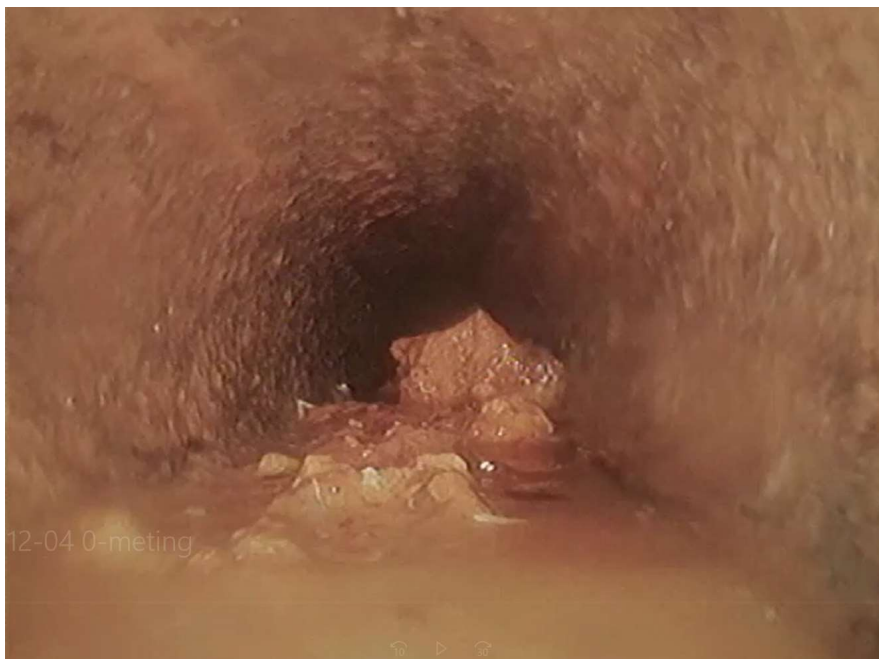
Figuur B3.2 Beeld klein stukje verder in horizontale leiding. Er zijn losse brokken afzettingsmateriaal zichtbaar (kon met camera worden weggeduwd). Onduidelijk waardoor dit is gekomen. Op deze leiding en achterliggend deel heeft nog niet eerder een reiniging plaatsgevonden
