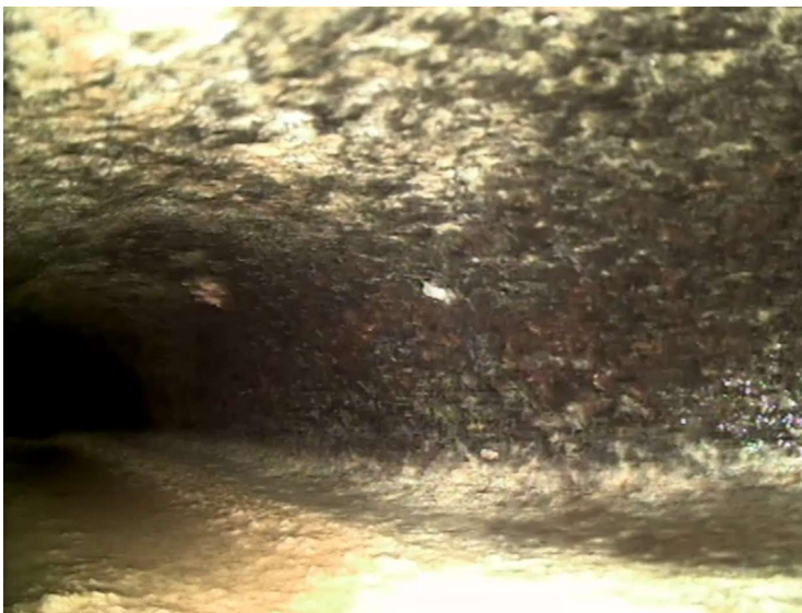
Figuur 4.11 Naar verwachting volgens tekening en de dikkere aangroei van afzettingen aan één kant is dit de horizontale leiding in de kruipruimte
