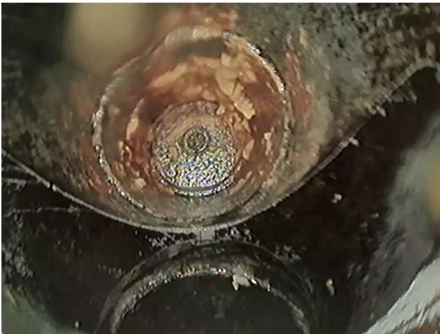
Figuur B4.14 Y-stuk, leiding onder gaat verder kruipruimte in, leiding boven is het ontstopningsstuk zoals ook zichtbaar op voorgaande foto. Camera was niet manoeuvreerbaar om in de onderste leiding verder te kijken, kwam niet verder dan ontstopningsstuk
