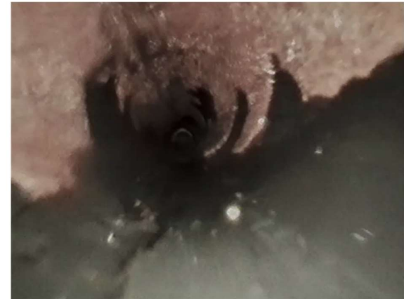
Figuur 4.15 Op rechterfoto is te zien dat de afzetting die links zat (zie linker foto) is weggespoten
