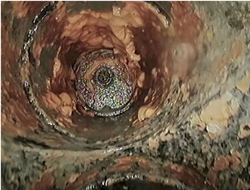
Figuur B4.7 Y-stuk, leiding onder gaat verder kruipruimte in, leiding boven is het ontstoppingsstuk zoals ook zichtbaar op voorgaande foto. Camera was niet manoeuvreerbaar om in de onderste leiding verder te kijken, kwam niet verder dan ontstoppingsstuk
