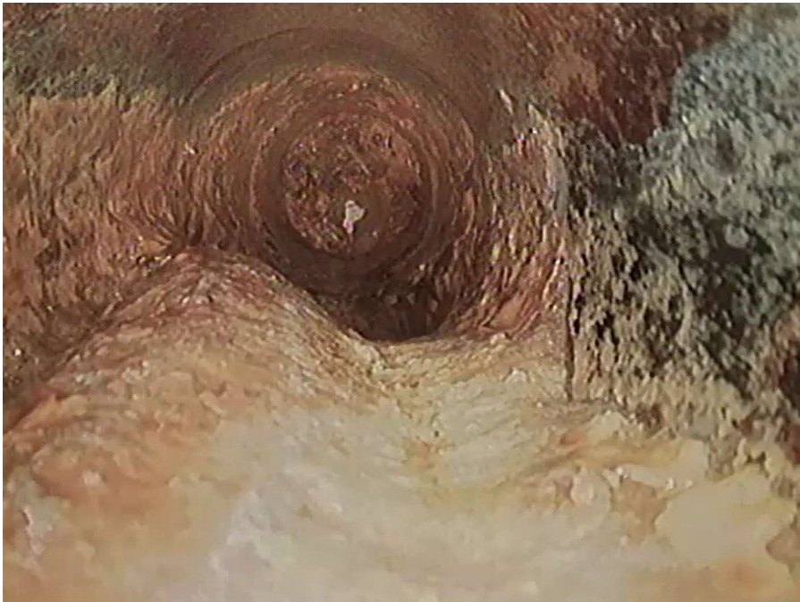
Figuur B3.15 Beeld net na zaagtand met op achtergrond ontstopningsstuk (flens) zichtbaar
