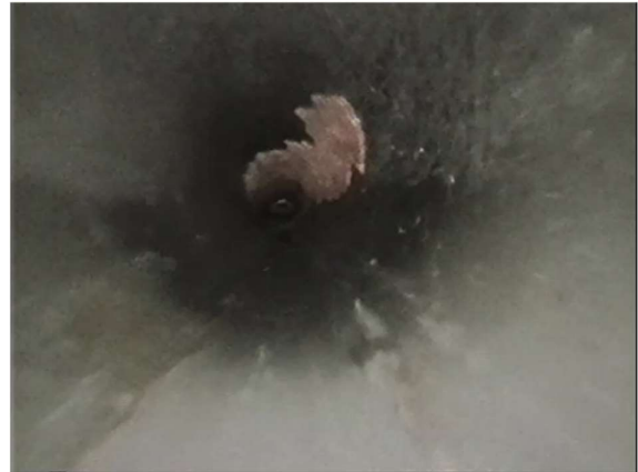
Figuur 4.15 Op rechterfoto is te zien dat de afzetting die links zat (zie linker foto) is weggespoten
