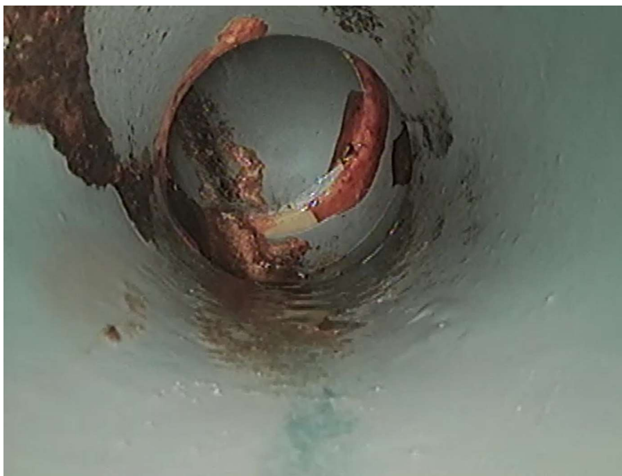
Figuur B1.20 Verder in rioolstelsel als voor reiniging omdat camera nu verder kon komen
