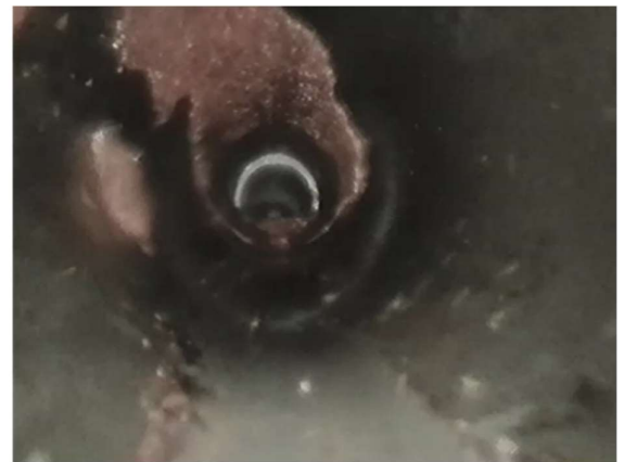
Figuur 4.17 Op rechterfoto is te zien dat aan de bovenkant afzettingen zijn weggespoten
