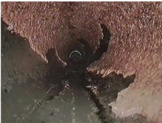
Figuur 4.16 Iets meer afzetting nog weggespoten, maar effect hier beperkt
