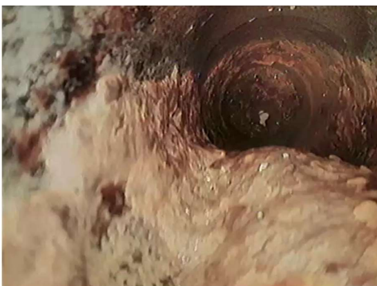
Figuur 4.21 Beeld net na zaagtand met op achtergrond ontstoppingsstuk (flens) zichtbaar
