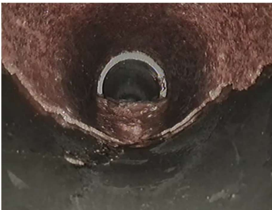
Figuur 4.17 Op rechterfoto is te zien dat aan de bovenkant afzettingen zijn weggespoten
