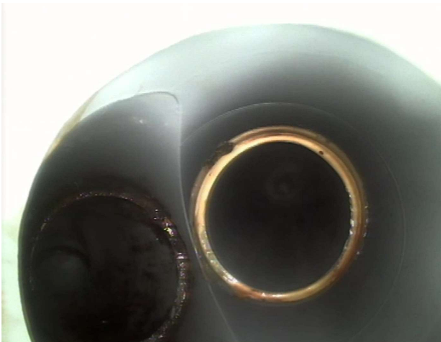
Figuur B2.12 Stukje verder in de verticale leiding, aftakking zichtbaar
