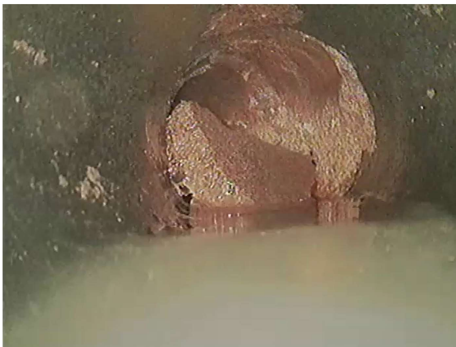
Figuur B1.36 Vlak voor bocht met daarbij zichtbaar een stuk losgelaten afzetting die bocht blokkeert. Hogedrukreiniging nogmaals herhaalt
