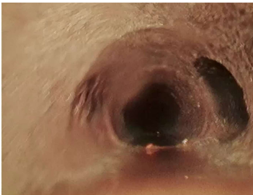
Figuur B4.96 Beeld met daarop de inprikkende leiding (rechts) van appartementencomplex 1 (op circa 5 m in leiding vanaf inspectiepunt)
