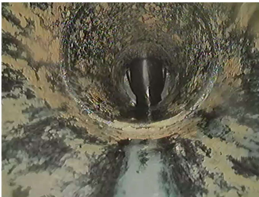
Figuur B4.24 Beeld van afsluiter. Deze was tijdens inspectie dicht gedraaid om te voorkomen dat de gehele wijk zonder vacuüm komt te zitten tijdens inspectiewerkzaamheden
