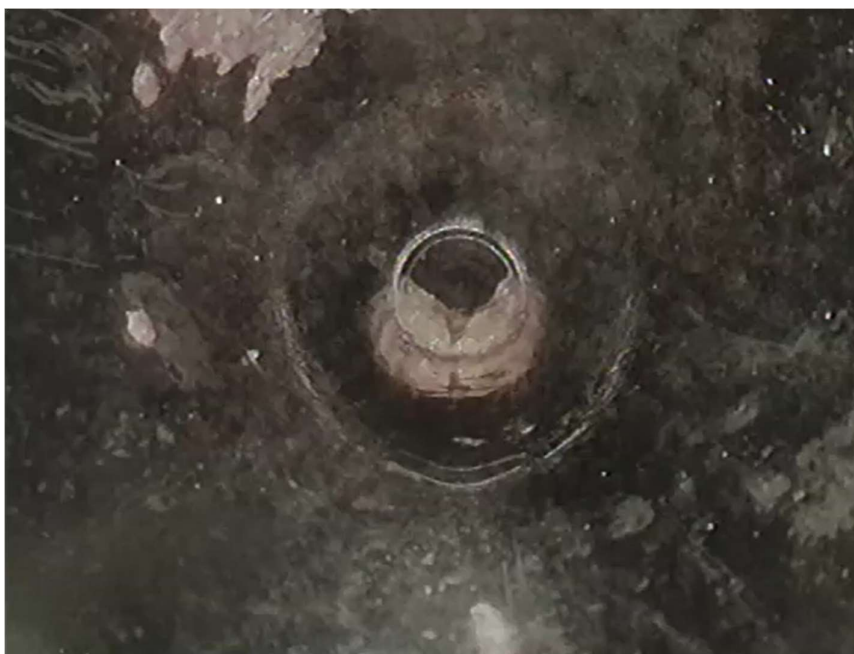
Figuur B3.89 Beeld voor overgangsstuk. Camera kwam niet verder
