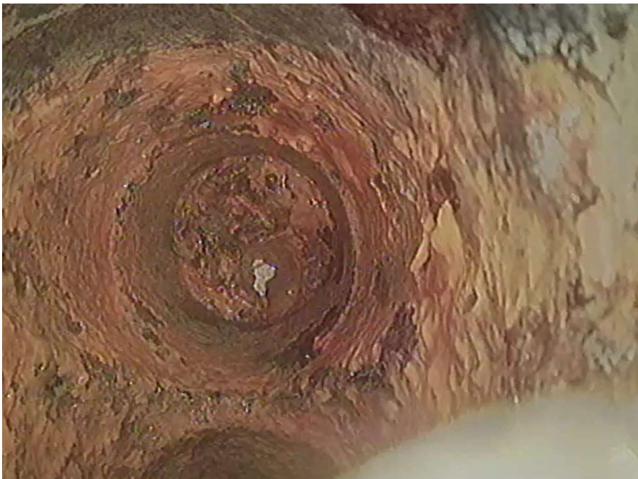
Figuur B3.16 Y-stuk, leiding onder gaat verder kruipruimte in, leiding boven is het ontstopningsstuk zoals ook zichtbaar op voorgaande foto. Camera was niet manoeuvreerbaar om in de onderste leiding verder te kijken, kwam niet verder dan ontstopningsstuk
