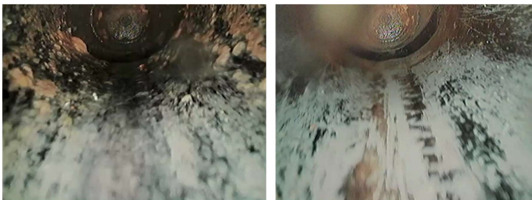
Figuur 4.28 Beeld net na zaagtand met op achtergrond ontstoppingsstuk (flens) zichtbaar
