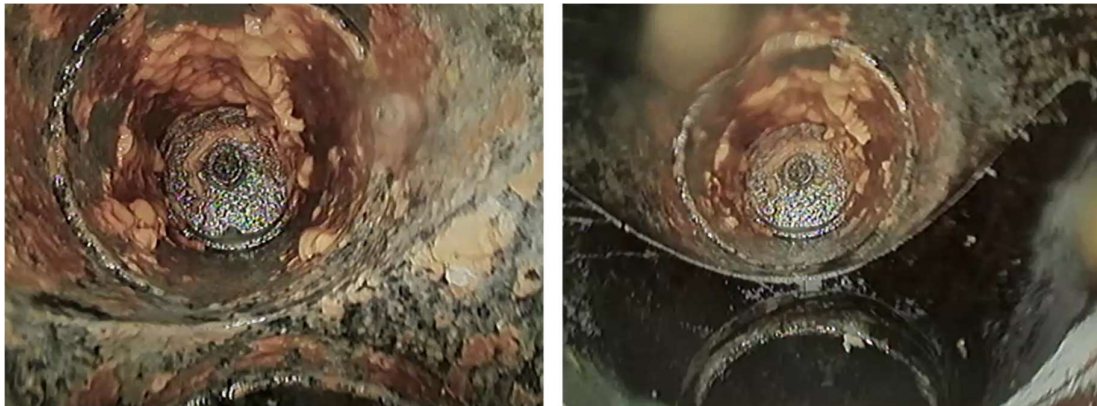
Figuur 4.29 Y-stuk, leiding onder gaat verder kruipruimte in, leiding boven is het ontstoppingsstuk zoals ook zichtbaar op voorgaande foto. Camera was niet manoeuvreerbaar om in de onderste leiding verder te kijken, kwam niet verder dan ontstoppingsstuk
