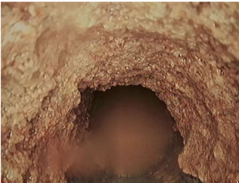
Figuur B2.66 Beeld direct na voorgaande bocht. Camera kwam niet verder en aan de beelden te zien kon de hoge druk spuit ook niet verder
