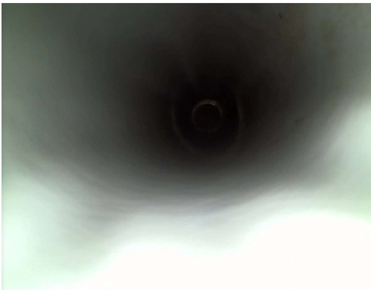
Figuur 4.13 Beeld net na voorgaande bocht, verticale leiding. Vanaf hier is de leiding verder helemaal schoon
