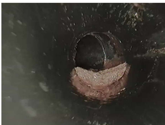
Figuur 4.13 Op rechterfoto is klein stuk afzetting weggespoten
