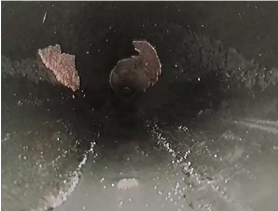
Figuur 4.15 Op rechterfoto is te zien dat de afzetting die links zat (zie linker foto) is weggespoten
