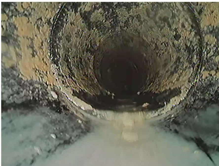
Figuur B4.22 Beeld van overgangsstuk in leiding van Ø 63 mm naar Ø 75 mm
