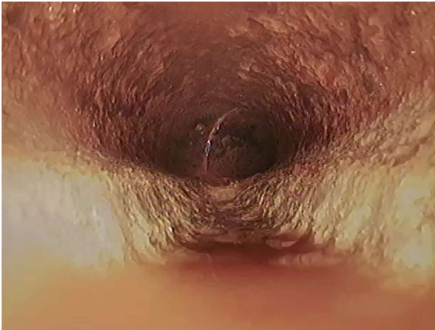
Figuur B2.71 Beeld vlak voor bocht. Camera kwam niet verder
