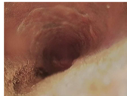
Figuur 4.25 Rechts is foto zichtbaar direct in/na bocht. Camera kwam niet verder vanwege de vele afzettingen. De hoge druk spuit is zo te zien ook voor de bocht al vast gelopen
