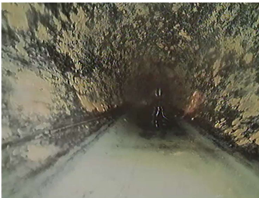
Figuur B4.23 Beeld leiding Ø 75 mm met in verte afsluiter zichtbaar
