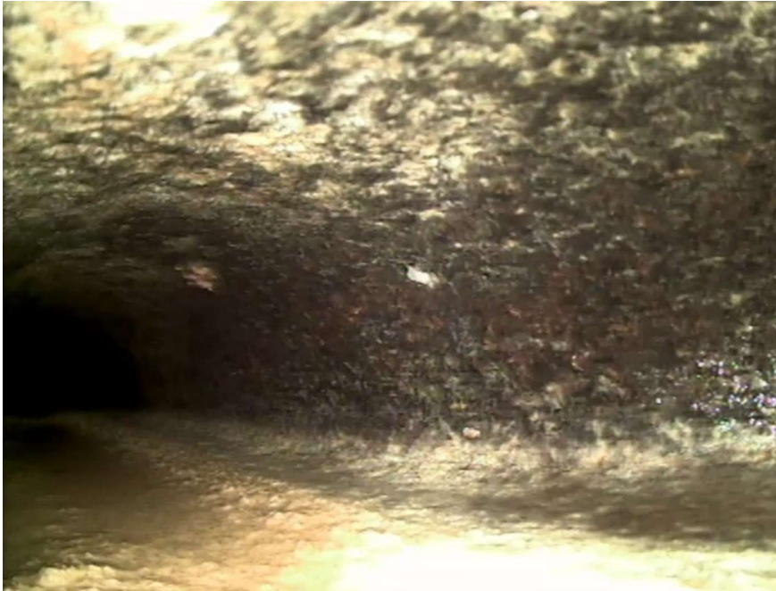
Figuur B2.7 Beeld na bocht voorgaande foto. Naar verwachting volgens tekening en de dikkere aangroei van afzettingen aan één kant is dit de horizontale leiding in de kruipruimte
