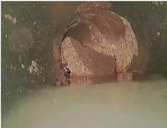
Figuur 4.24 Een los stuk afzetting zichtbaar links die de doorgang voor de camera blokkeerde. Rechts is zichtbaar dat het stuk is weggespoten
