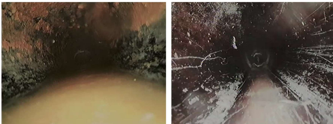
Figuur 4.26 Beeld stuk verder in zelfde leiding als voorgaande foto met in verte zaagtand zichtbaar
