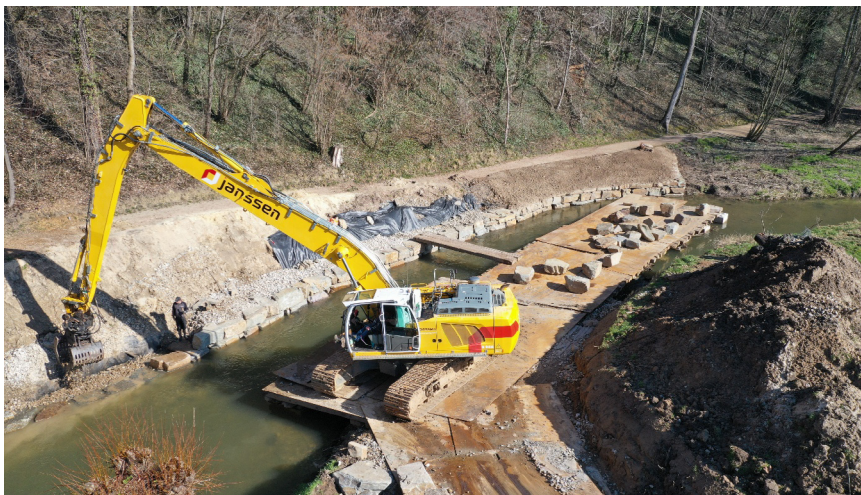
FIGUUR 11 HERSTELWERKZAAMHEDEN VALKENBURG ZOMER 2021 20 (WATERSCHAP LIMBURG)
