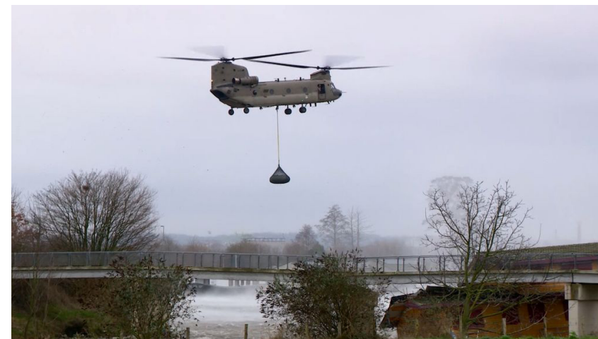
FIGUUR 7 HET UITVOEREN VAN NOODMAATREGELEN AAN DE DAMBREUK IN DE OVERLAAT BOSSCHERVELD, UITGEVOERD DOOR DEFENSIE IN JANUARI 2024 TIJDENS DE HOOGWATERPERIODE ( HTTPS://WWW.PZC.NL/VIDEO/PRODUCTIE/CHINOOK-HELIKOPTERS-HELPEN-BIJ-OPBOUW-NOOD-DAM-MAASTRICHT-420000-420000?REFERRER=HTTPS%3A%2F%2FWWW.GOOGLE.COM%2F )
