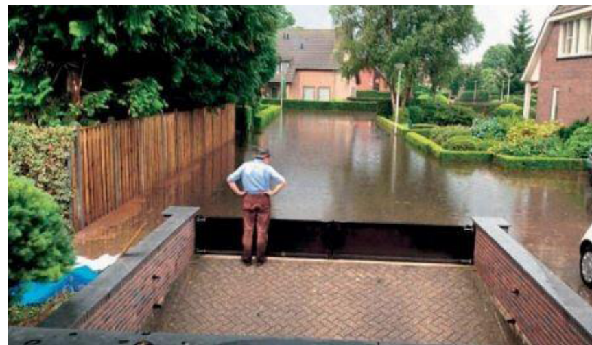
FIGUUR 5 WATERKERENDE SCHOTTEN PLAATSEN 12
