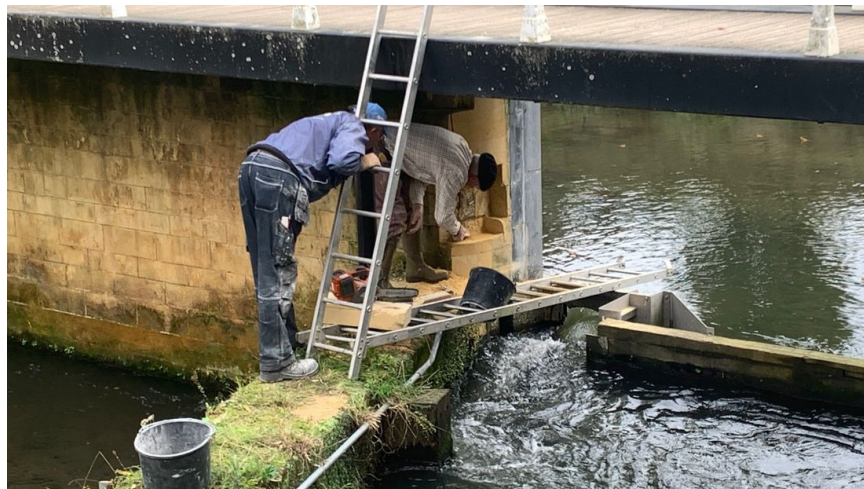
FIGUUR 6 DE MUREN BIJ DE VISTRAP IN VALKENBURG WORDEN HERSTELD 16
