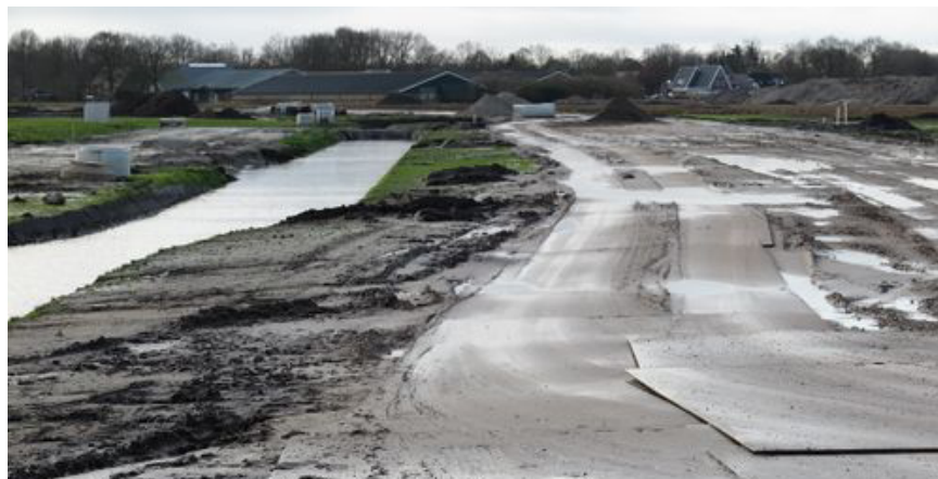
FIGUUR 12 RIJPLATEN OM EEN MODDERIG GEBIED TOEGANKELIJK TE MAKEN 21
