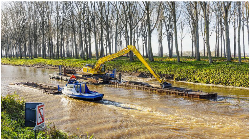
FIGUUR 10 WERKZAAMHEDEN MIDDENDIJK (BE) 19
