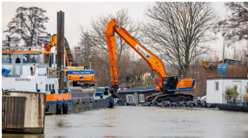
FIGUUR 8 HET UITVOEREN VAN HERSTELMAATREGELEN AAN DE DAMBREUK IN DE OVERLAAT BOSSCHERVELD, UITGEVOERD DOOR RIJKSWATERSTAAT IN APRIL 2024 NA DE HOOGWATERPERIODE ( HTTPS://WWW.L1NIEUWS.NL/NIEUWS/2362206/NOODDAM-AAN-EINDE-VAN-DE-DAG-KLAAR )
