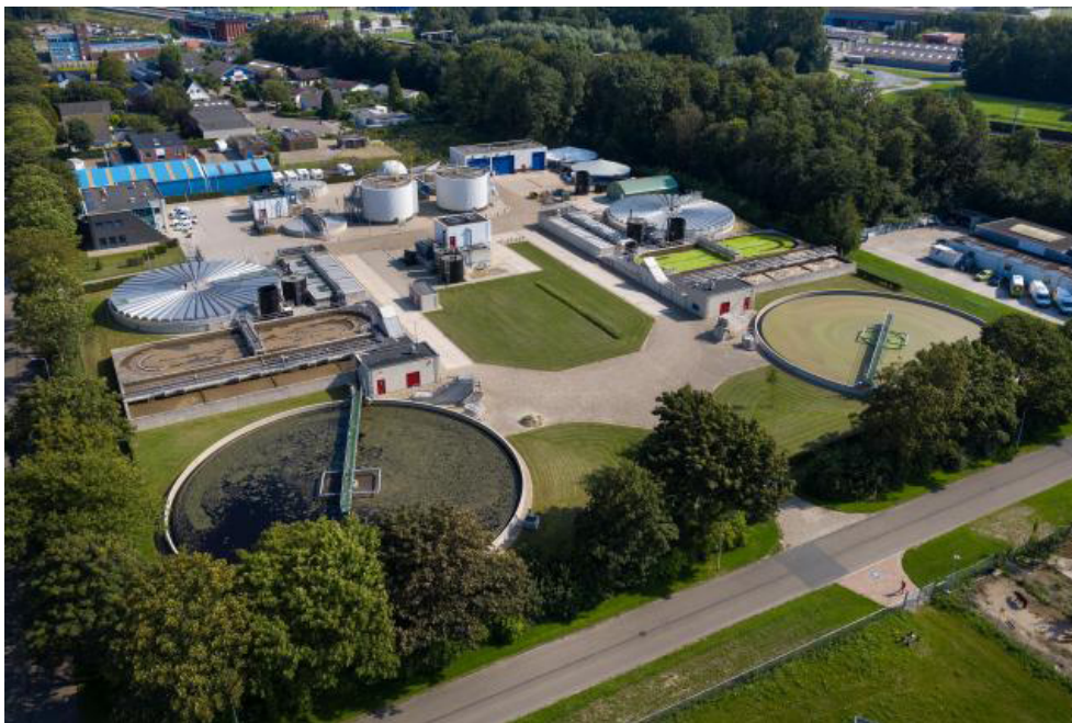
Foto van rwzi Dronten, waterschap Zuiderzeeland
