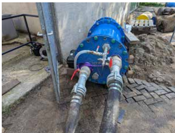
Figuur 3.8 Lanceerinrichting nadat de Acquarius is ingebracht, inclusief de toevoerslangen van de tijdelijke pompinstallatie
