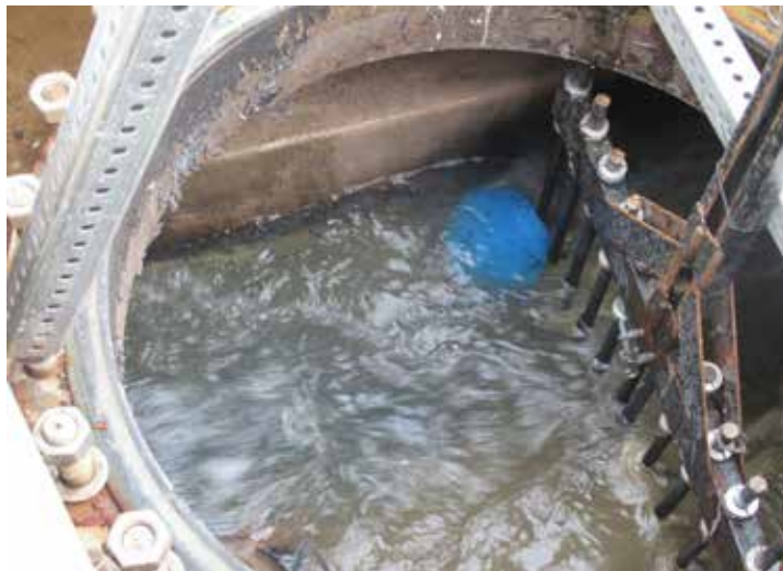
Figuur 3.4 Smartball komt aan bij de ontvangstput, waar deze wordt opgevangen door een tijdelijk geïnstalleerd rooster
