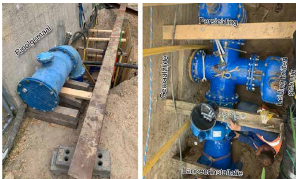
Figuur 2.4 Lanceerinrichting (l) en het kruis onderaan de lanceer- inrichting waarmee deze op de bestaande persleiding is aangesloten (r)
