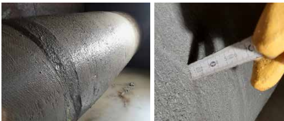
Figuur 4.15 Persleiding nadat deze aan de buitenkant is aangesmeerd
