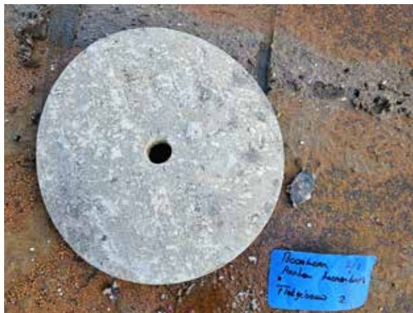
Figuur 3.11 Eén van de asbestcement boorkernen van dit project
