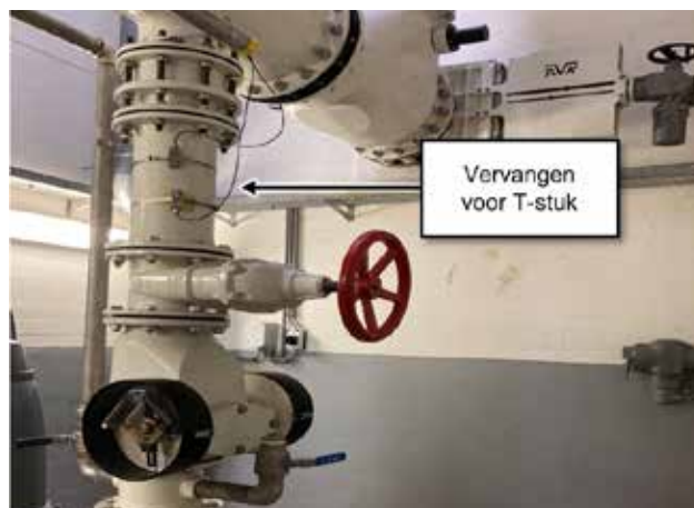
Figuur 2.3 Door Xylem voorgestelde aanpassing aan het gemaal om de Smartball in te brengen
