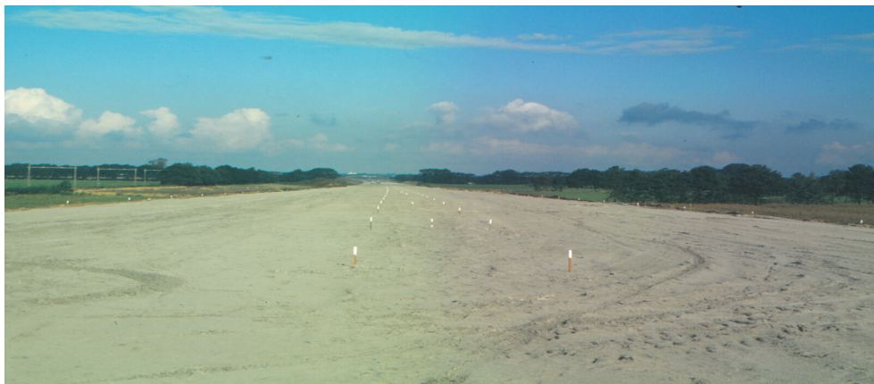
Figuur 1.1 Zandcunet rijksweg (bron: Sweco)
