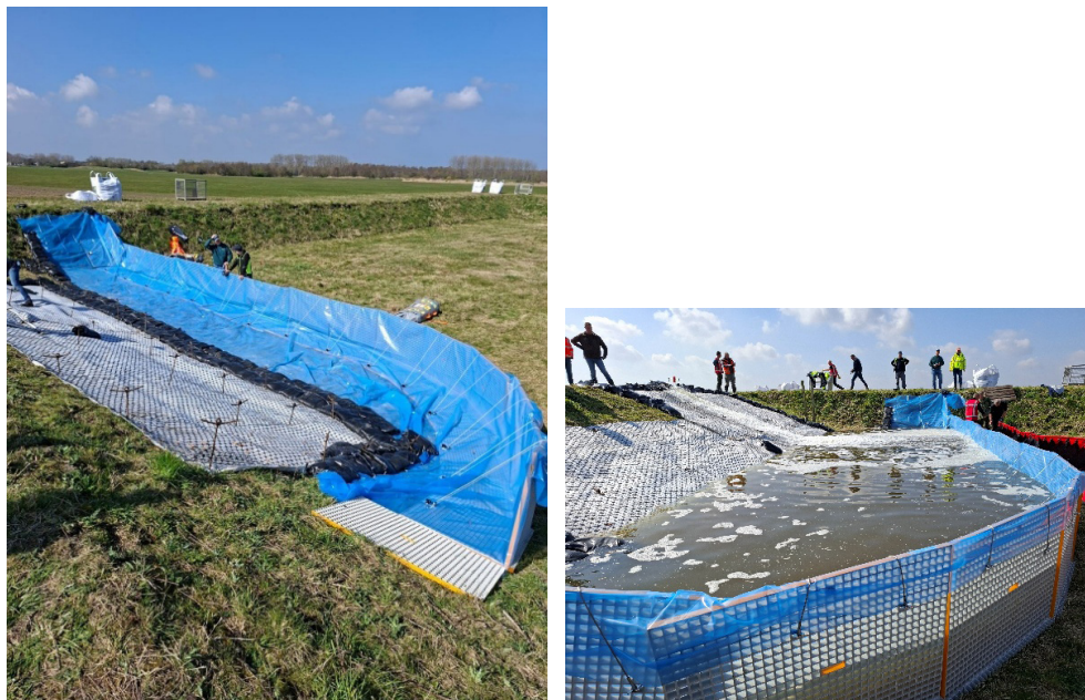
Figuur 2.59 Vullen van de bochtvormige Haawalbarrière met water.
