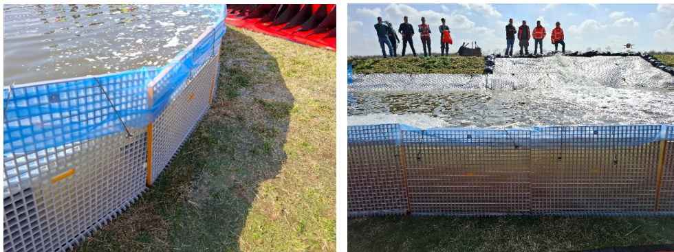
Figuur 2.62 De barrière is tot aan de bovenrand met water gevuld en begint over te lopen.
