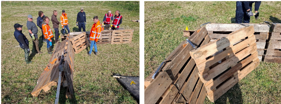
Figuur 2.16 E en 3-pallet systeem in L-vorm. De hoek is versterkt d.m.v. een extra pallet die met krammen is gefixeerd.
