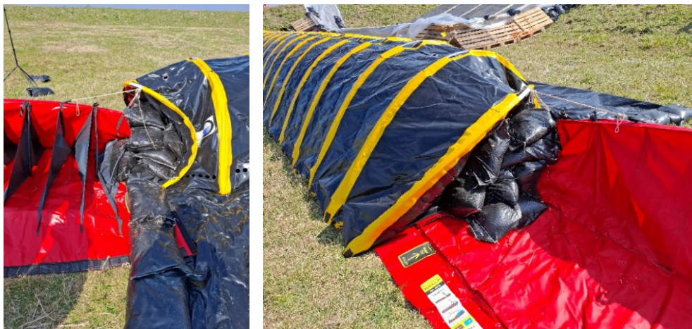
Figuur 2.78 Detailopname van de koppeling tussen BFW en TubeBarrier. Links: waterzijde, Rechts: beschermingszijde
