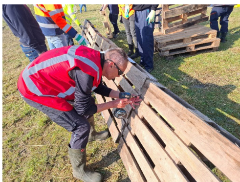
Figuur 2.20 De pallet aan de waterzijde wordt met de steunende pallet d.m.v. schroeven gefixeerd, waarbij de schroeven de planken van de kerende pallet aan de klossen van de steunende pallet verbinden.
