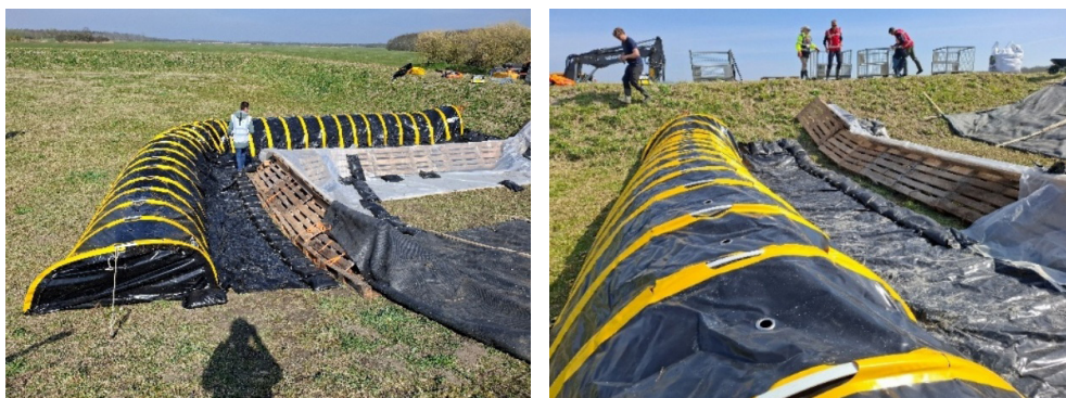
Figuur 2.42 Het schort van de TubeBarrier is opengevouwen, maar vanwege de beperkte ruimte t.o.v. de Europalletsbarrière ligt deze niet strak op de grond maar zitten er vele plooien in. De buitenrand van het schort is met zandzakken verzwaard om onderloopsheid te beperken.
