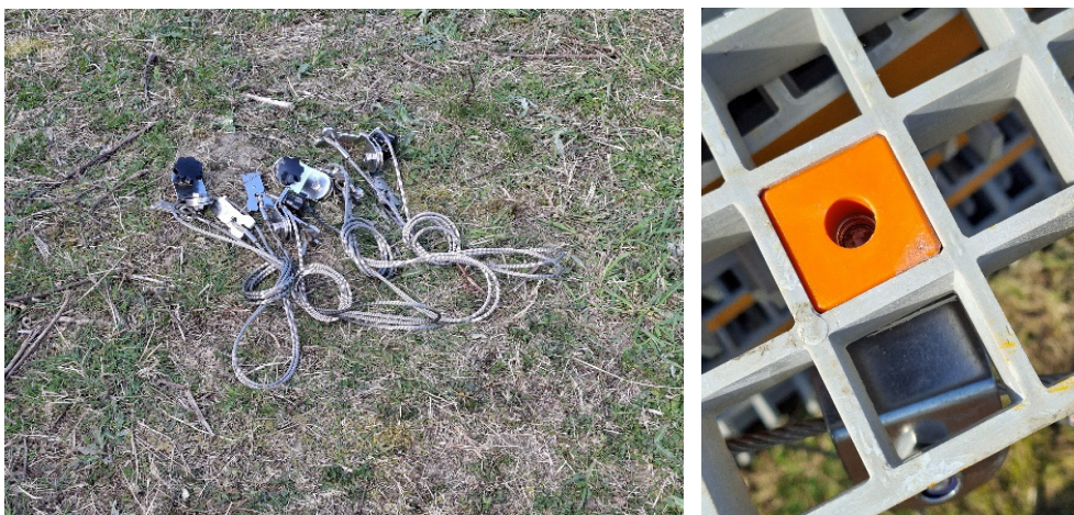
Figuur 2.54 Spandraden worden met het schroefelement aan de bodemplaat in de oranje gemarkeerde opening vastgeschroefd.
