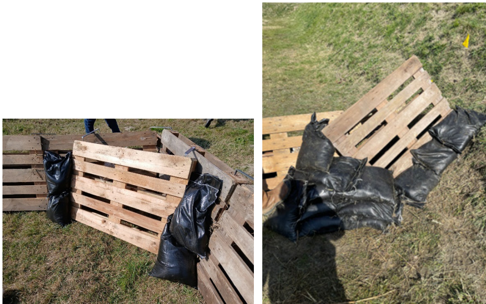
Figuur 2.18 Opvullen van de randen in de hoeken en bij de taludovergangen met zandzakken.
