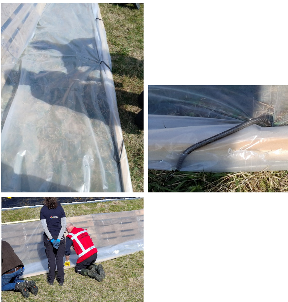
Figuur 2.25 Het andere uiteinde van de folie wordt om panlatten gerold en met U-krammen op de grond gefixeerd. Ook hier dient de folie plat op de grond te liggen zonder veel lucht of plooiën erin.
