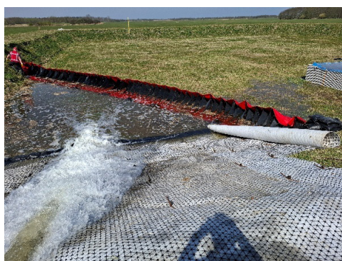
Figuur 2.82 Voor een goede aansluiting van de BFW met het talud worden zandzakken tegen de BFW aan geplaatst. Ook op het zeil dat op de grond ligt worden zandzakken als ballast geplaatst. Daarna wordt water over de Tensardoekebekramming ingeleid.
