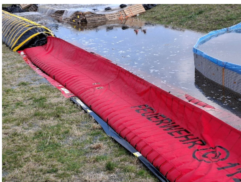
Figuur 2.80 Aan de achterkant van de BFW treedt lekwater als gevolg van onderloopsheid uit. De voorkant van de BFW is niet met zandzakken geballast waardoor het zeil gedeeltelijk opdrijft en er water onderdoor gaat stromen.
