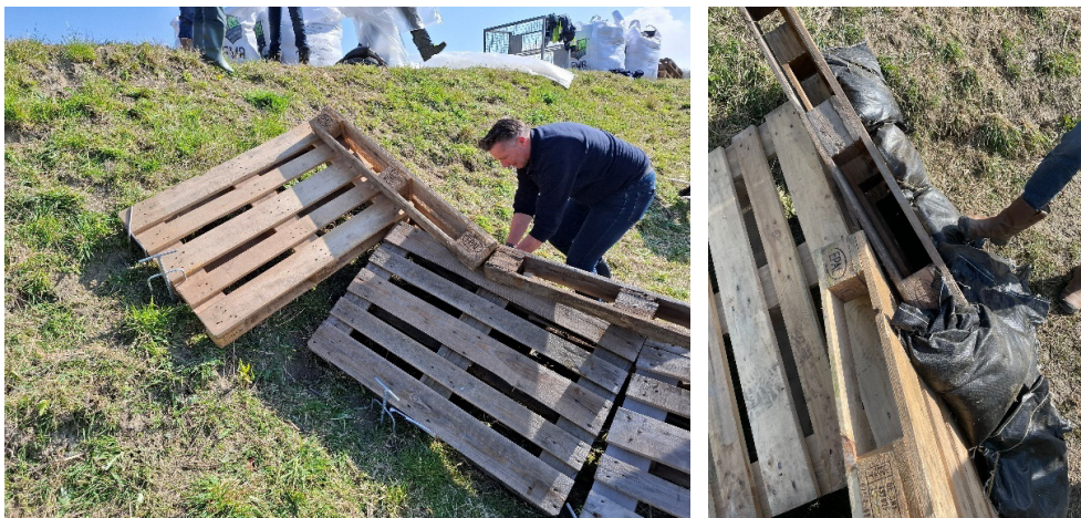
Figuur 2.22 Het plaatsen van de Europallets bij de overgang naar het talud blijkt iets moeilijker, omdat de elementen dan niet goed in elkaar grijpen bij een halfsteensverband. Hier moeten ook zandzakken worden toegepast om de open ruimtes naar de ondergrond goed af te dichten en voor stabiliteit te zorgen. Bovendien dienen de pallets met krammen te worden gefixeerd.
