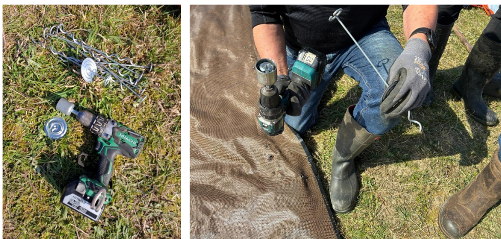
Figuur 3.7 Gripple schroeven met speciale adapter voor accuschroevendraaier
