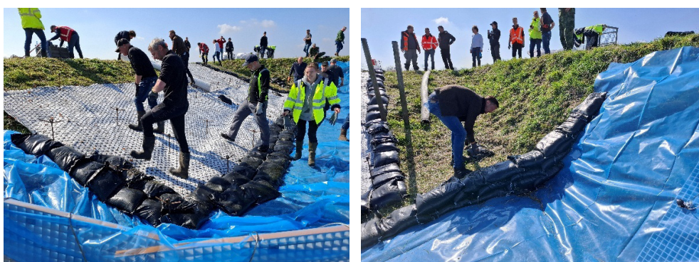
Figuur 2.57 Ballasten van de buitenkant van de folie met zandzakken om onderloopsheid te verminderen. Het valt op dat in de folie nog vele plooien zitten.
