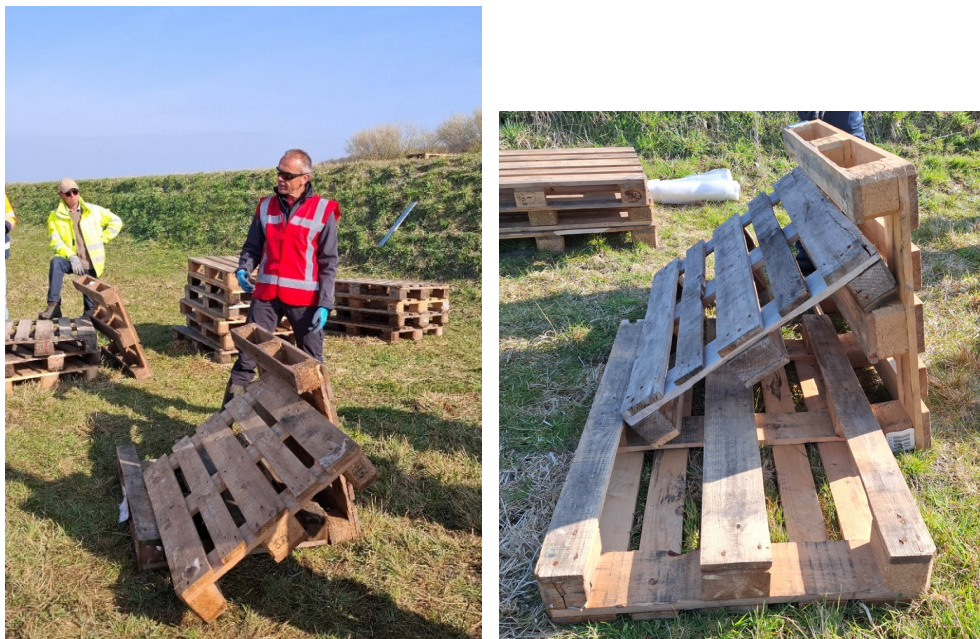
Figuur 2.13 Om bochten of rechthoekige richtingswisselingen te kunnen realiseren wordt een extra pallet op de smalle kant tegen de hoek aan geplaatst. Tussenruimtes worden met zandzakken gevuld. Folie ook onder de pallets vastklemmen om te voorkomen dat de folie gaat opdrijven.
