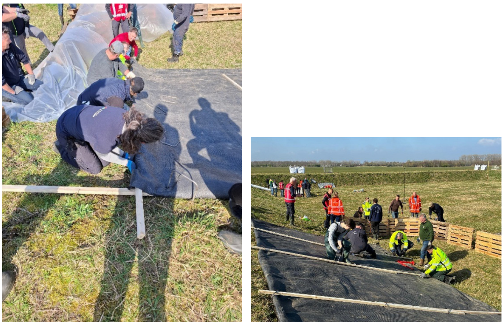
Figuur 3.11 Inrollen van de panlat aan de zijkant (links). Rechts: panlatten worden op het doek gelegd en met U-krammen in de grond gefixeerd.
