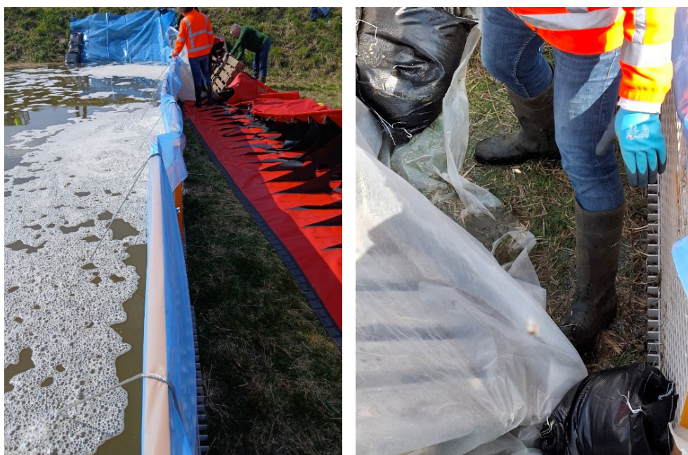
Figuur 2.60 Het bassin is nog niet volledig gevuld. Aan de randen bij de overgang naar het talud treedt al onderloopsheid op.
