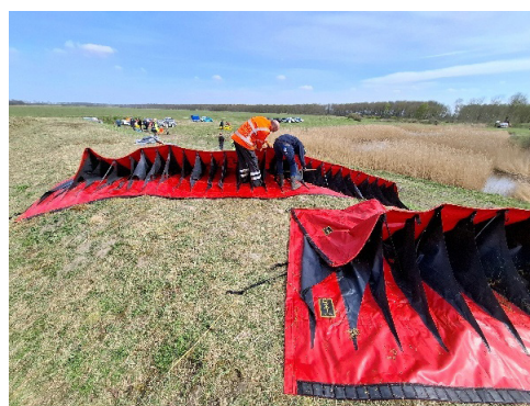
Figuur 2.85 Het gras werd rond drie weken van te voren gemaaid. Na de oefening bleek veel gras in de BFW te blijven hangen. Het schoonmaken ervan was heel arbeidsintensief.
