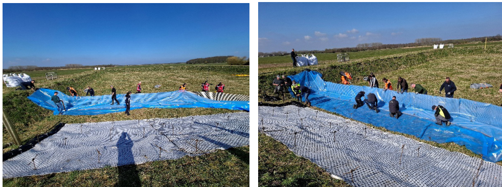
Figuur 2.56 Plaatsen en ontvouwen van de waterdichte folie en folie tegen de hoek aan de binnenkant duwen.
