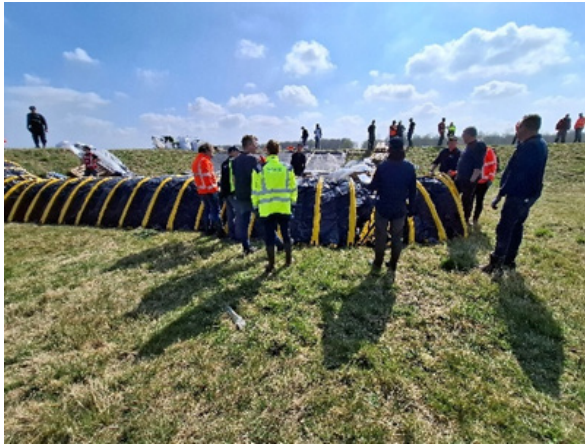
Figuur 2.37 2 TubeBarrier modules van 10 m lengte worden aan elkaar gekoppeld. Bij het verplaatsen van de uit elkaar getrokken “Tubebarrierharmonica” bleek het heel moeilijk hier een goede houvast te vinden. Er zijn aan de bovenzijde geen handgrepen of lussen aangebracht om de TubeBarrier in een andere positie te kunnen draaien.
