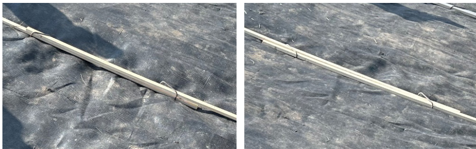
Figuur 3.12 Links: detail van op elkaar leggen van twee panlatten op het talud; rechts: detail van naast elkaar leggen van twee panlatten op het talud. Het naast elkaar aanbrengen van twee latten werd door de deelnemers als steviger beschouwd.
