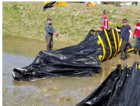
Figuur 2.46 De TubeBarrier gaat niet vanzelf helemaal leeglopen. De nog met restwater gevulde TubeBarrier is heel zwaar en kan alleen met veel moeite worden verplaatst.
