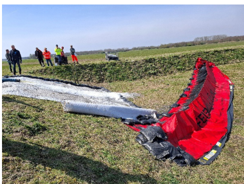
Figuur 2.82 Voor een goede aansluiting van de BFW met het talud worden zandzakken tegen de BFW aan geplaatst. Ook op het zeil dat op de grond ligt worden zandzakken als ballast geplaatst. Daarna wordt water over de Tensardoekebekramming ingeleid.
