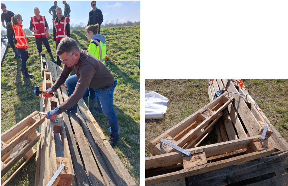
Figuur 2.17 Onderlinge fixatie van de Europallets met stevige korte stalen U-krammen.
