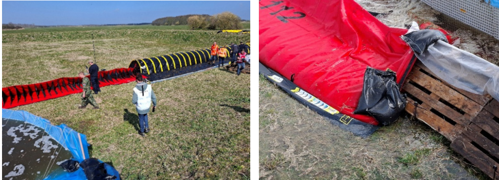
Figuur 2.77 Links: Aansluiting van het BFW systeem aan een TubeBarrier en aan een Europallet barrière bij de overgang naar het dijktaalud. Rechts: Detail van de aansluiting van het BFW systeem aan een Europallet barrière.
