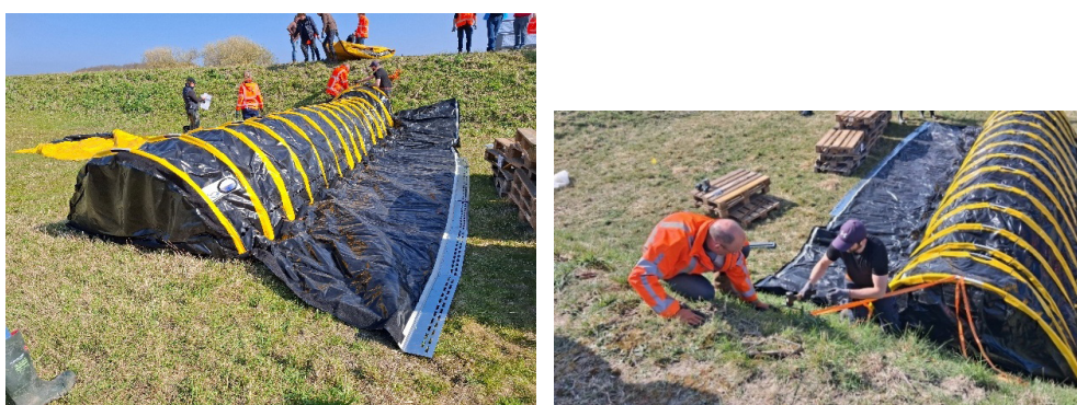
Figuur 2.41 Verankering van de TubeBarrier met spanbanden tegen het talud aan.
