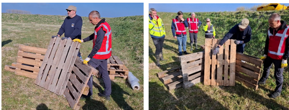
Figuur 2.13 Om bochten of rechthoekige richtingswisselingen te kunnen realiseren wordt een extra pallet op de smalle kant tegen de hoek aan geplaatst. Tussenruimtes worden met zandzakken gevuld. Folie ook onder de pallets vastklemmen om te voorkomen dat de folie gaat opdrijven.
