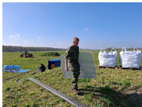
Figuur 2.51 In het midden van de modules is een opening om de modules makkelijk met één hand te kunnen dragen.
