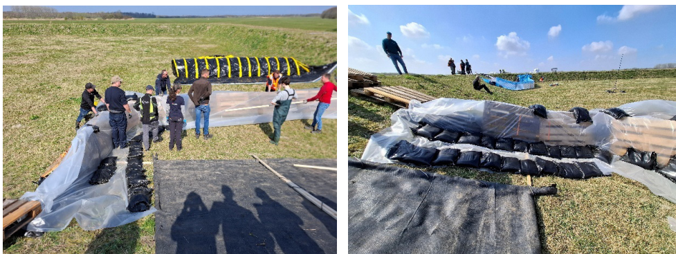
Figuur 2.23 Bij de 3-pallet methode wordt de folie voornamelijk met zandzakken gefixeerd, zowel aan de bovenkant van de mobiele kering als direct aan de waterkerende onderkant tegen de pallets aan. De folie dient plat op de grond te liggen zonder plooiën en aan de rand met zandzakken te worden geballast om onderloopsheid te voorkomen.
