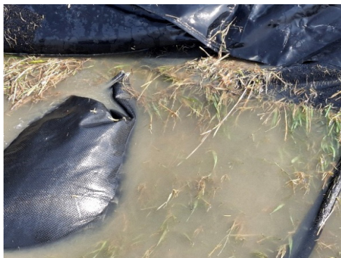
Figuur 2.46 De TubeBarrier gaat niet vanzelf helemaal leeglopen. De nog met restwater gevulde TubeBarrier is heel zwaar en kan alleen met veel moeite worden verplaatst.
