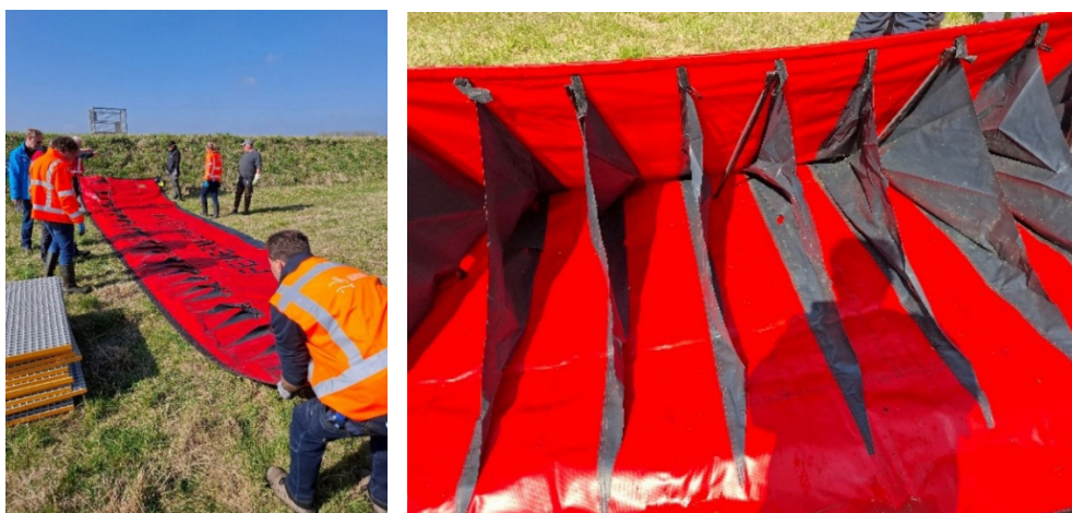
Figuur 2.75 Om het BFW-systeem ook zonder water opgeklapt te kunnen houden worden steunen ingezet.
