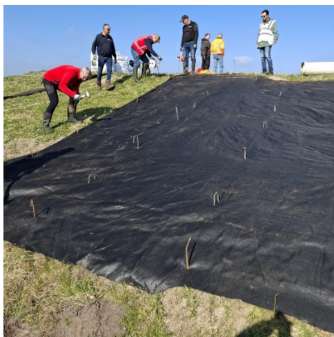
Figuur 3.18 Aanleg van een traditionele bekramming, hier met een woven geotextiel. Plaatsen van L-pennen van 30 cm lengte.
