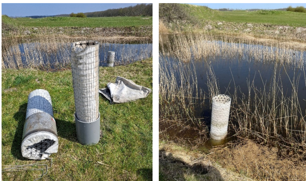
Figuur 4.7 Wellenhoed als alternatieve maatregel voor het opkisten van zandmeevoerende wellen
