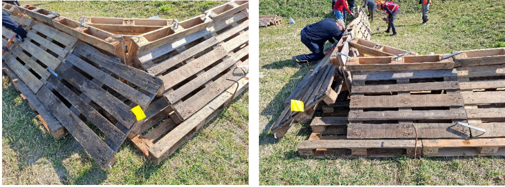
Figuur 2.15 Het 3-pallet systeem wordt in halfsteensverband middels metalen krammen aan elkaar gekoppeld.
