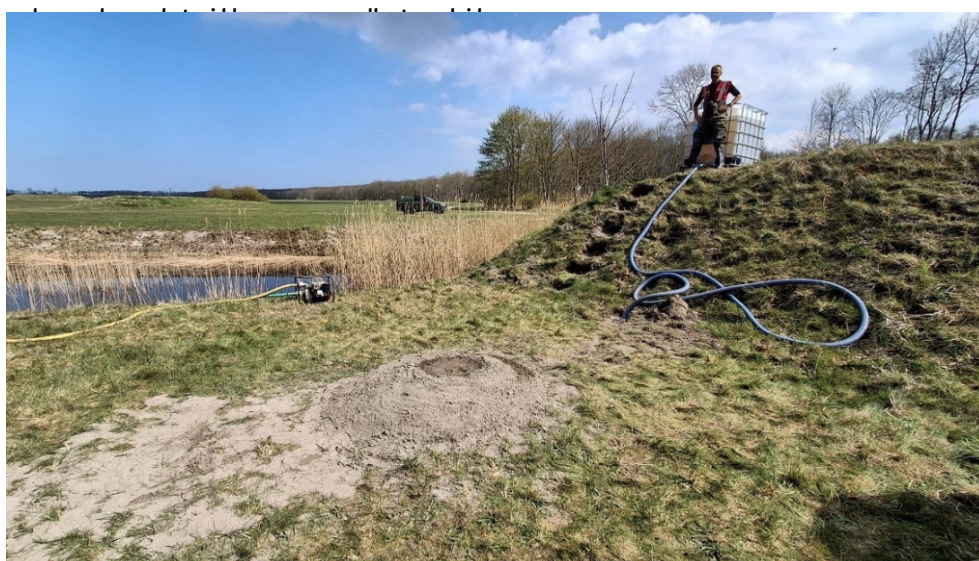
Figuur 4.4 Om het uitzien van een zandmeevoerende wel na te bootsen word water vanuit een waterreservoir via een slang
