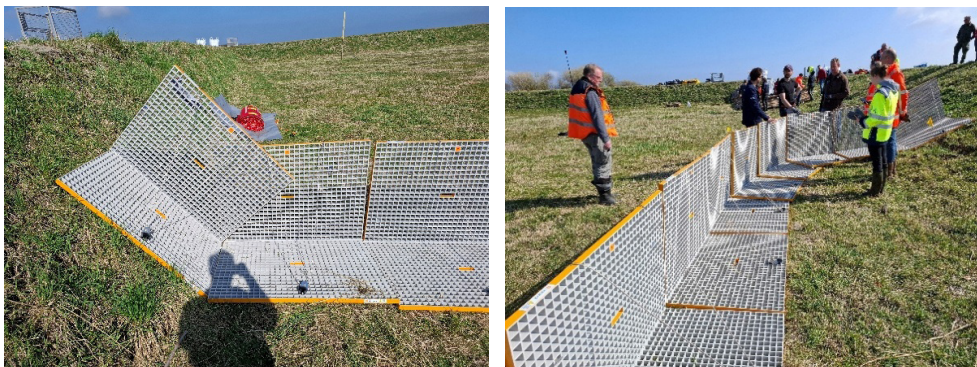
Figuur 2.53 Uitvoering van de constructie bij de overgangen naar de dijktafsluiters.
