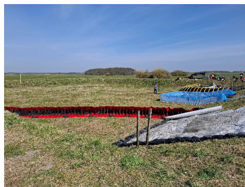
Figuur 2.81 Het BFW systeem wordt diagonaal in een van de hoeken van het bassin van talud naar talud geplaatst.
