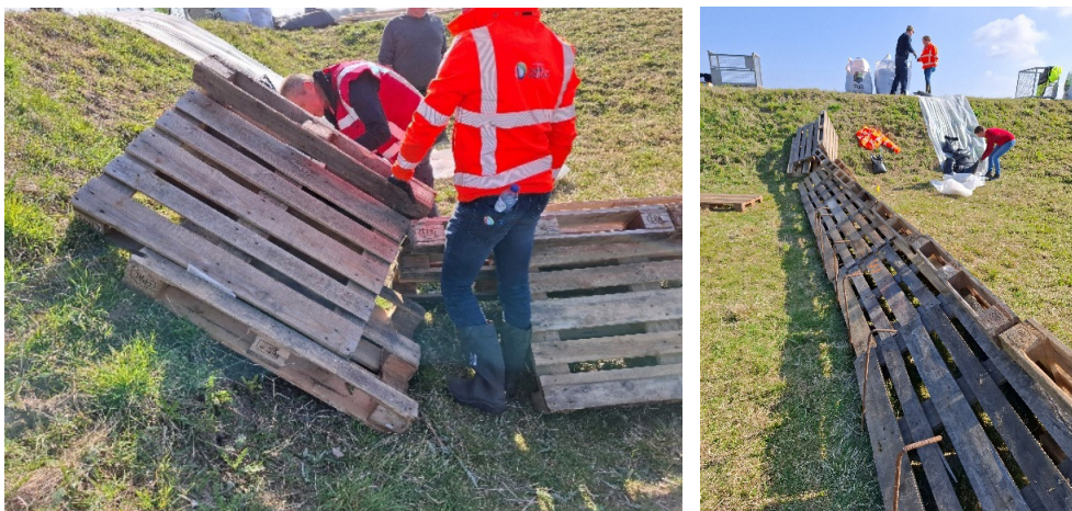
Figuur 2.22 Het plaatsen van de Europallets bij de overgang naar het talud blijkt iets moeilijker, omdat de elementen dan niet goed in elkaar grijpen bij een halfsteensverband. Hier moeten ook zandzakken worden toegepast om de open ruimtes naar de ondergrond goed af te dichten en voor stabiliteit te zorgen. Bovendien dienen de pallets met krammen te worden gefixeerd.
