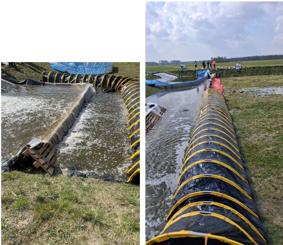
Figuur 2.44 Het gebied tussen de Europalletbarrière en TubeBarrier laat men vollopen met water. Het gebied achter de TubeBarrier is duidelijk verzadigd van het onderstromend lekwater.
