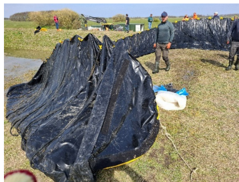
Figuur 2.47 Om het restwater helemaal te kunnen lossen wordt de TubeBarrier onderste boven op een helling geplaatst
