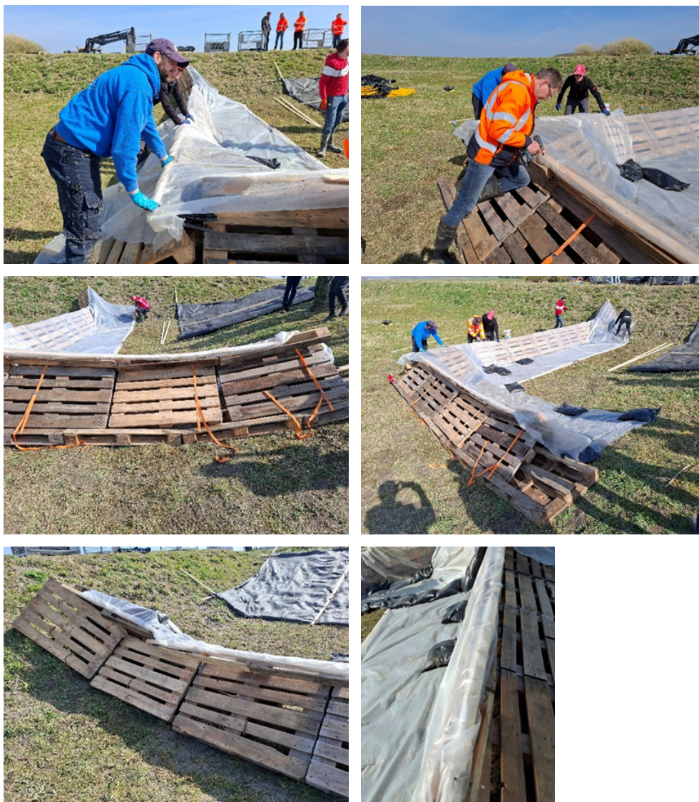
Figuur 2.27 Inrollen van de panlatten in de folie naar de niet waterkerende kant toe. Hierdoor ontstaat een strakke, gladde kant waar het water beter overheen kan lopen.
