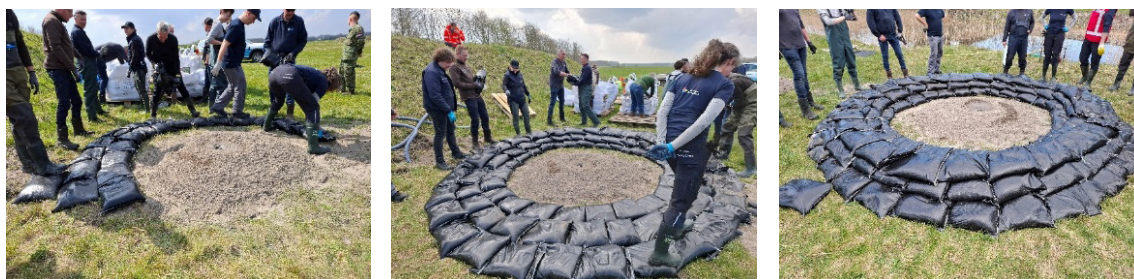
Figuur 4.6 Opbouw van een opkisting met zandzakken, waarbij elke zandzaklaag door erover te lopen goed vast wordt. Niet aanstampen!
