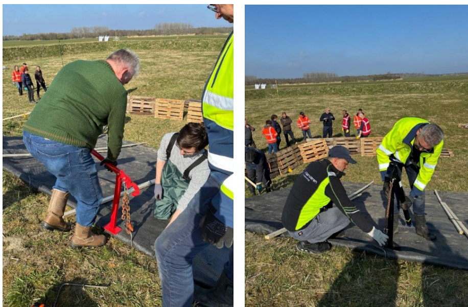
Figuur 3.14 Trekken van de krammen met verschillende types paaltrekkers
