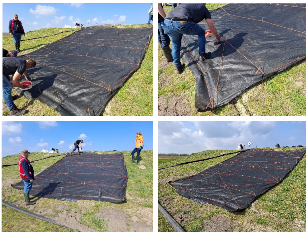
Figuur 3.19 Vastzetten van het doek met een lang dun touw met hoge treksterkte, dat om de pennen heen wordt gesponnen. Het touw wordt vastgemaakt aan een pin, waarna het vanaf de rol wordt afgerold en over het zeil wordt gespannen.
