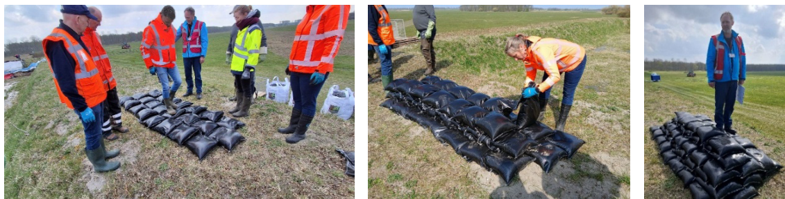
Figuur 4.3 Zandzakken worden in de eerste laag zo gestapeld dat de kont van de tweede zak op de kop van de eerste zandzak wordt gelegd. De tweede en derde laag worden in halfsteensverband ten opzichte van de eerste laag gestapeld. De vierde dan weer in halfsteensverband t.o.v. de derde laag.
