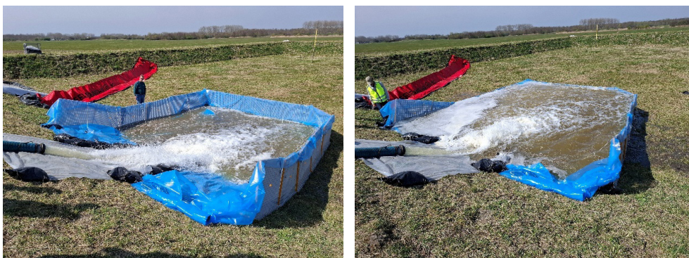
Figuur 2.66 Vullen van het Haawalbassin met water. Aan de rechterkant is al een vernatting van het grasveld achter de kering als gevolg van onderloopsheid te zien.
