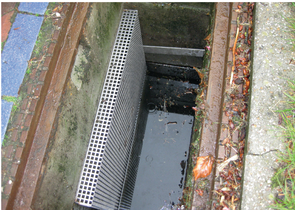
Figuur 3.2 Voorbeeld vuilfilter in kolk: grove vervuiling wordt afgevangen en fijne delen bezinken in de zandvang (bron: gemeente Rheden)
