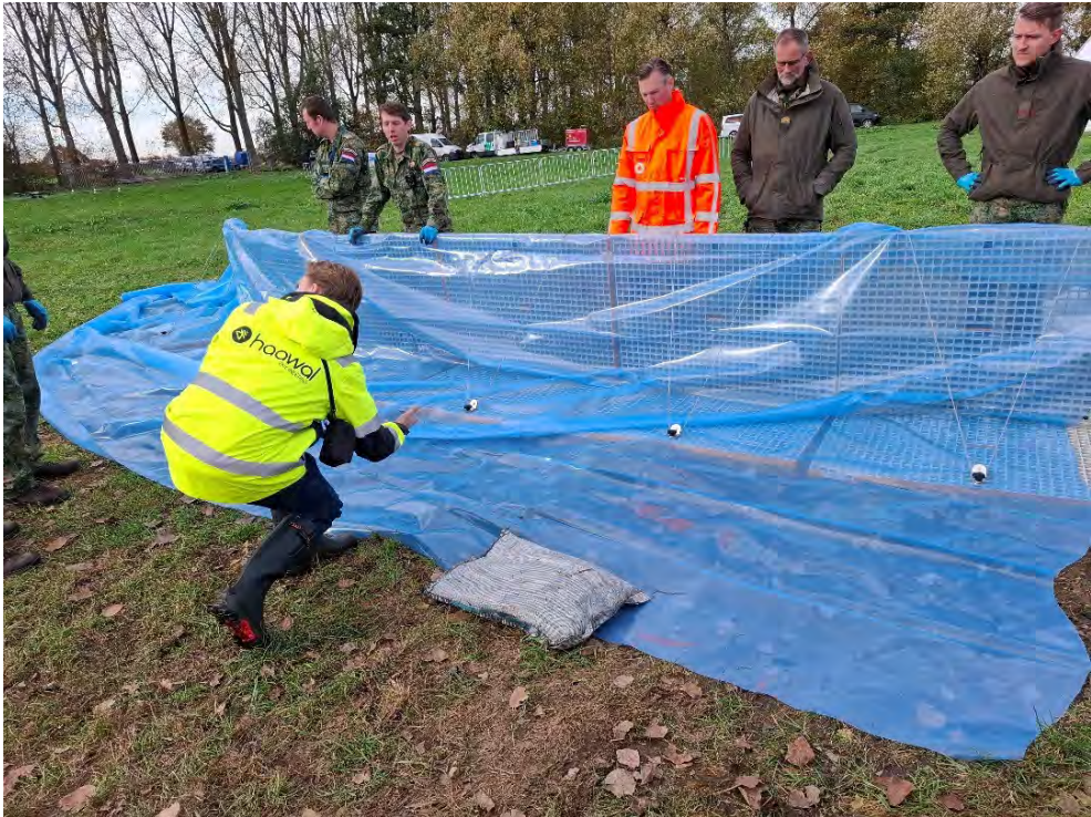
Figuur D.96 Het membraan wordt aan elke module verankerd en de buitenrand wordt met een rij zandzakken geballast.
