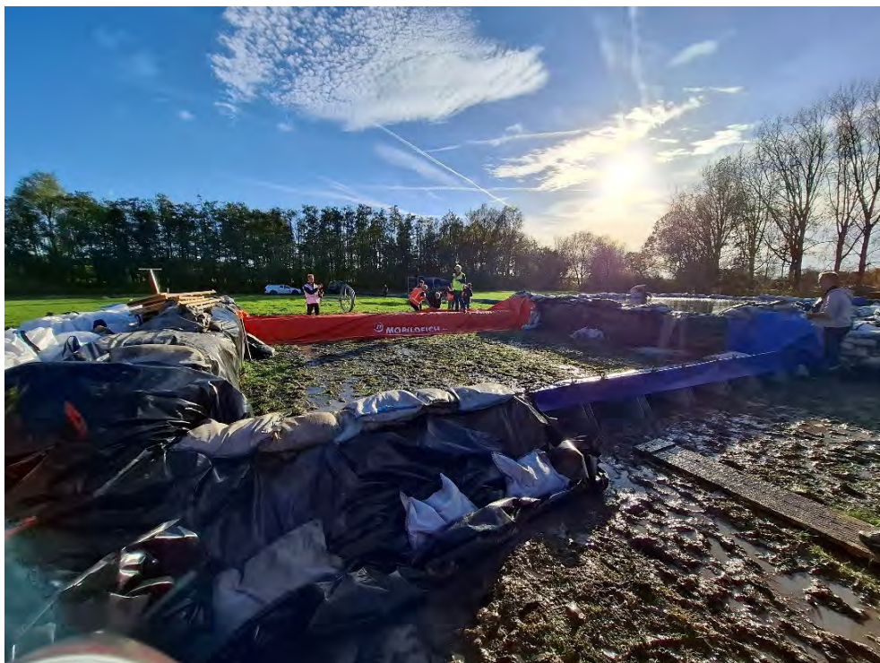
Figuur D.61 Testbassin met aan de voorkant een zandzakdam en daarnaast een Geodesign Barrier. In de achtergrond een Mobildeich.
