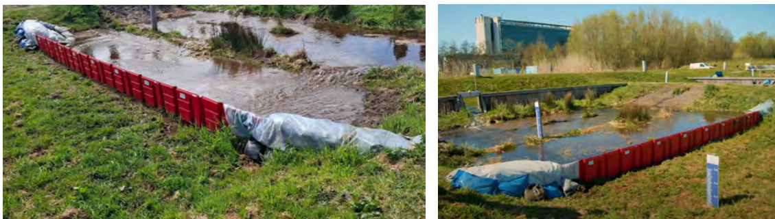
Figuur A.14 Waterschotdam sluit aan twee hellingen aan. Aansluitingen zijn met zandzakken en folie afgedicht.
