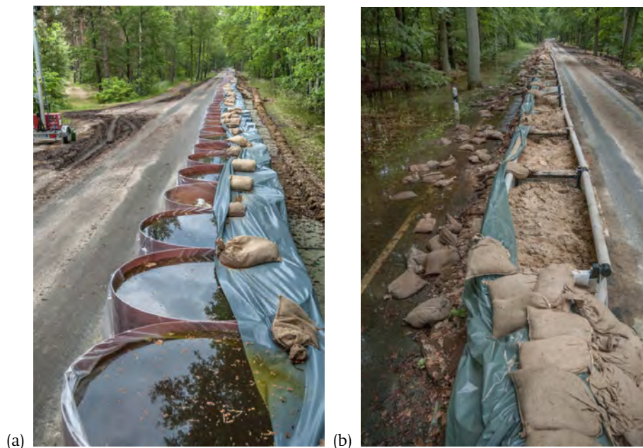
Figuur 1.12 ZVS in de buurt van Gartow (Nedersaksen, Duitsland) na de overstroming van de Elbe in 2013 met behulp van (a) AQUARIWA en (b) Quick Damm type E (Lankenau e.a., 2020).
