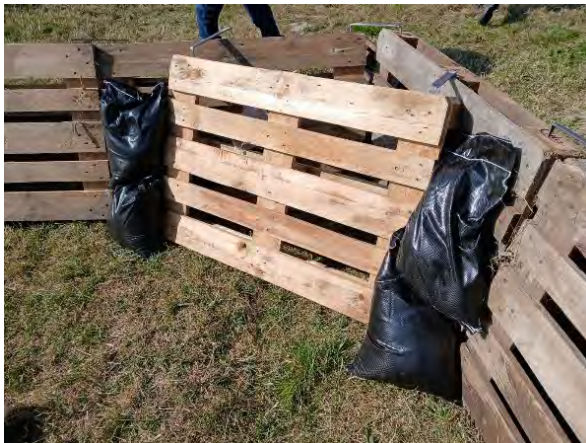
Figuur C 100 Opvullen van de randen in de hoeken met zandzakken.
