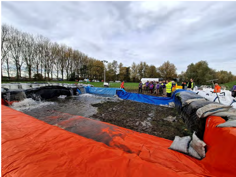
Figuur D.62 Vullen van het testbassin. Situatie met in de achtergrond een combinatie van twee wandssystemen (links paneelsysteem Haawal en rechts het framesysteem Geodesign Barrier).
