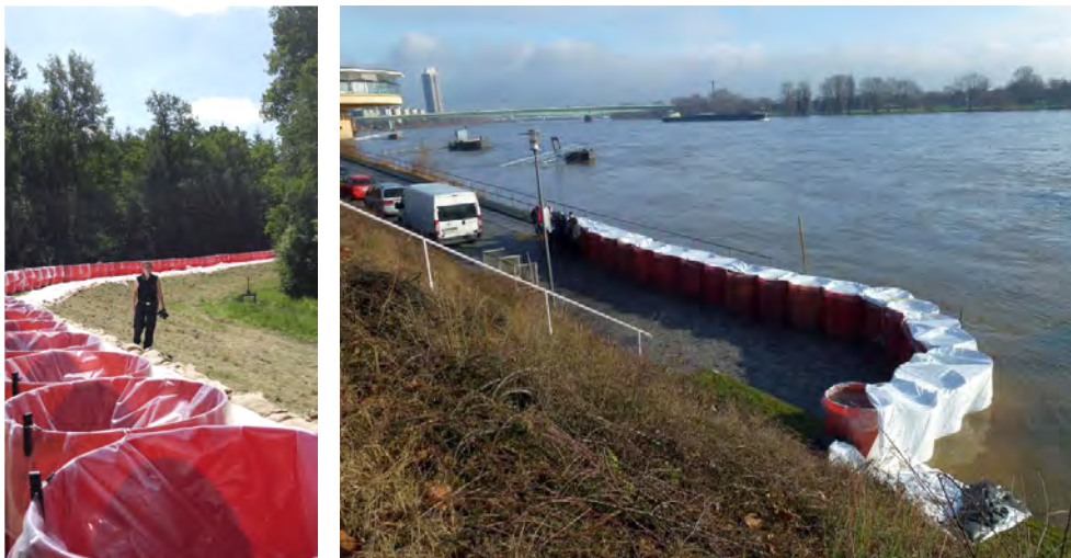
Figuur C 9 AQUARIWA-systeem op een dijkkruin en bij een kademuur.
