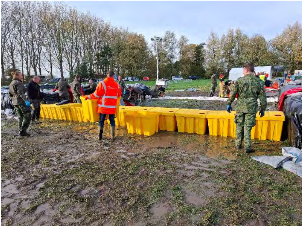
Figuur D.78 Voor extra stabiliteit tegen verschuiving worden in een tweede rij extra BoxBarriers geplaatst.
