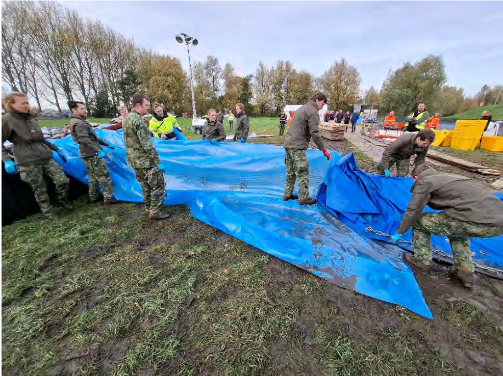
Figuur D.99 De overgang naar de Geodesign- Barrier wordt door het overlappen van het membraan van het Haawal-systeem met het zeil van de Geodesign Barrier afgedicht.
