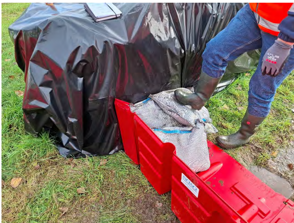
Figuur D.30 Aan de linkerkant is het gevelement helemaal niet gekoppeld aan het vorige element, maar alleen boven elkaar geplaatst. Beide elementen zijn daarom met zandzakken geballast en afgedicht.
