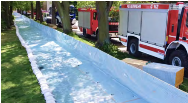
Figuur A.4 Een Haawal-barriere met de folie ca. 2 m naar de waterkant uitgetrokken en met zandzakken geballast om onderloopsheid te voorkomen.
