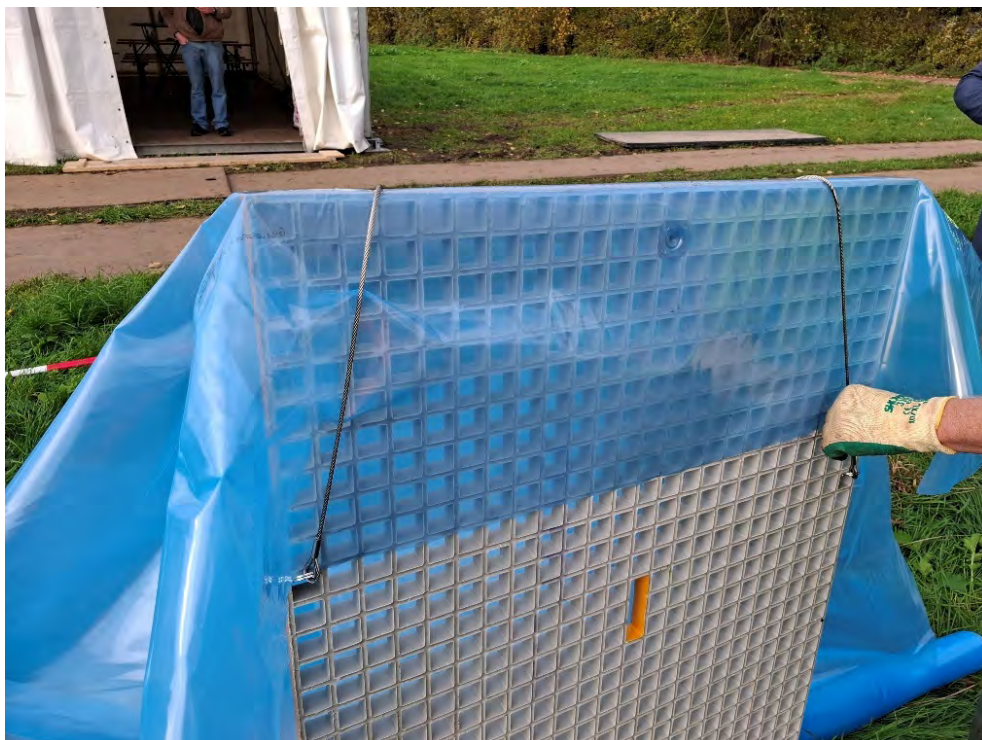
Figuur D.89 Daarna worden kabeleinden over het rooster gelegd en aan de achterkant van het rooster vastgehaakt.
