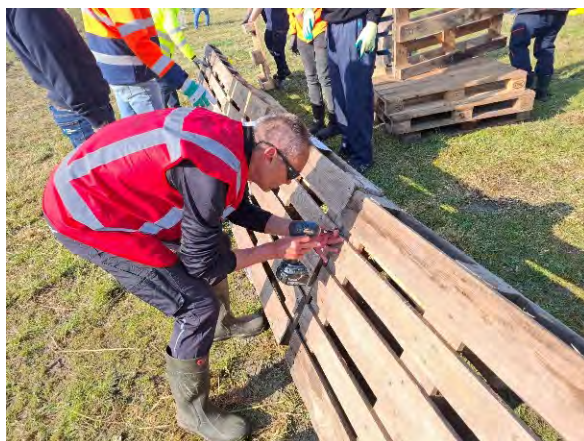
Figuur C 105 De pallet aan de waterzijde wordt met de steunende pallet d.m.v. schroeven gefixeerd, waarbij de schroeven de planken van de kerende pallet aan de klossen van de steunende pallet verbinden.
