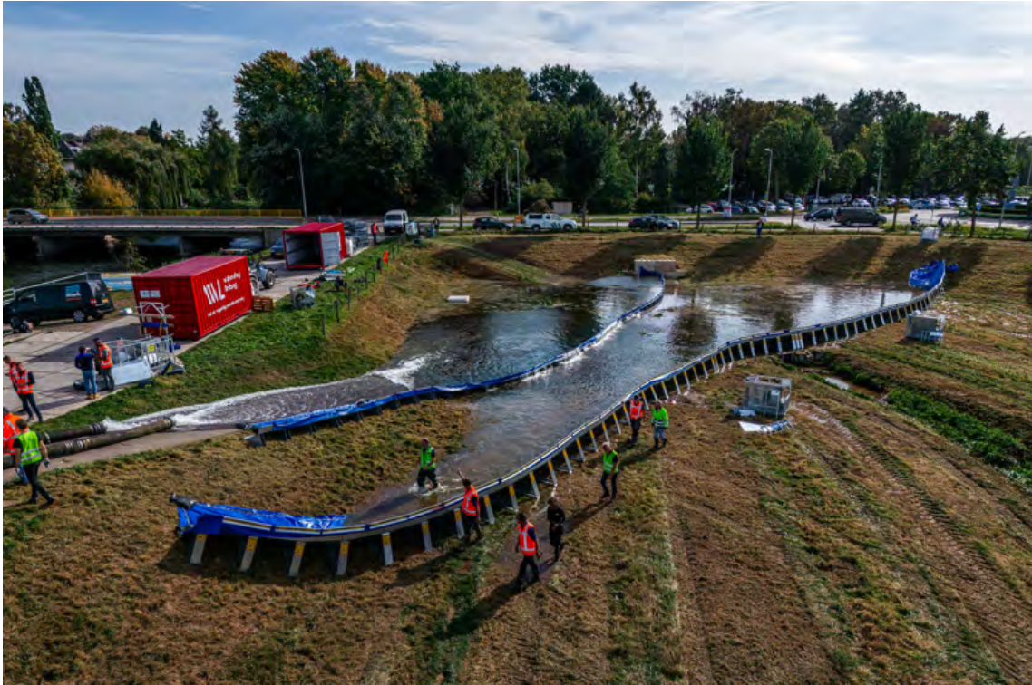
Figuur 5.2 Testlocatie Field Lab bij Waterschap Limburg in Roermond, test van twee stroken met de Geodesign Barrier, één langs een verharde weg en één op het onregelmatige grasterrein.
