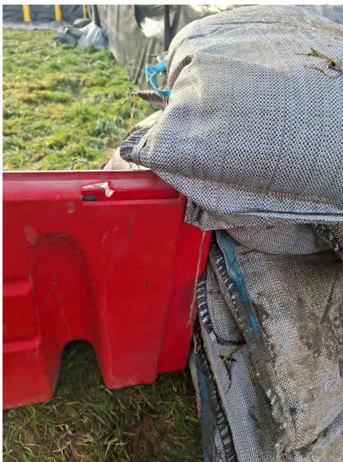
Figuur D.29 Ook hier is de nog beschikbare ruimte niet voldoende zodat de contactpunten van het laatste rechte element met het gevelement niet veilig in elkaar grijpen.
