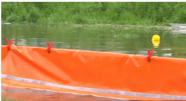
Figuur A.16 Met een zeil tegen onderloopsheid verstevigd Waterschot-systeem. Het zeil is met veerklemmen aan de bovenkant gefixeerd. (foto: Eric Reneerjens, https://www.wevideo.com/view/3082419423 )
