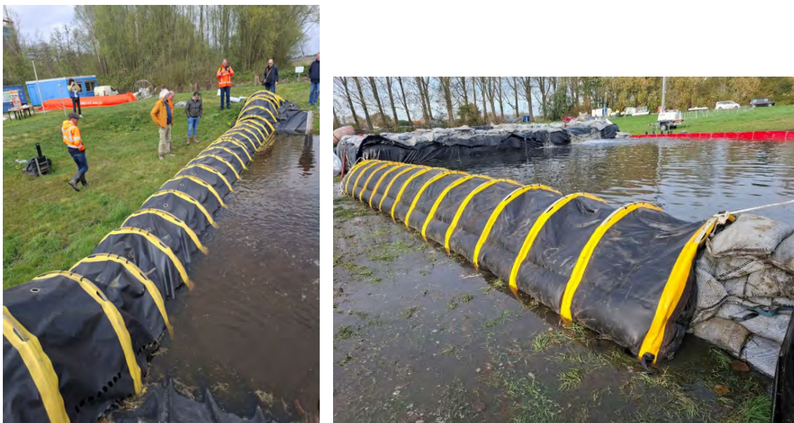
Figuur C 86 De eind van de TubeBarrier sluiten normaliter aan tegen muren of kades of op hogere gronden. Bij een lengtetekort de openblijvende ruimte opvullen met zandzakken. Hier valt op dat het schort niet voldoende effectief tegen onderloopsheid werkt.
