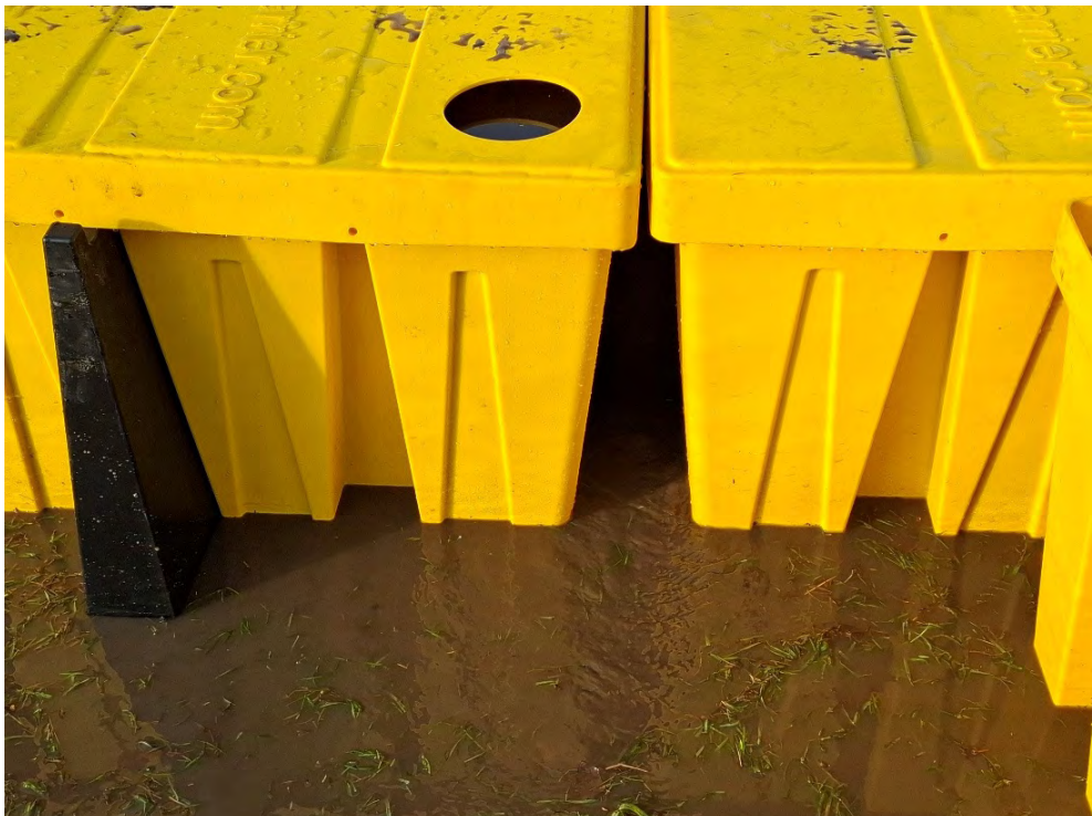
Figuur D.84 Duidelijk zichtbare lekstroom.
