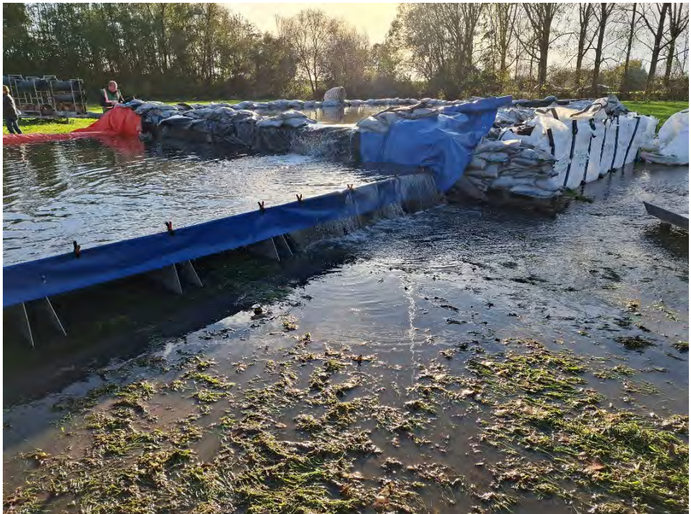
Figuur D.64 Bassin is gevuld tot aan bovenkant Geodesign Barrier. Nabij de zijkant van het bassin treedt overloop op.
