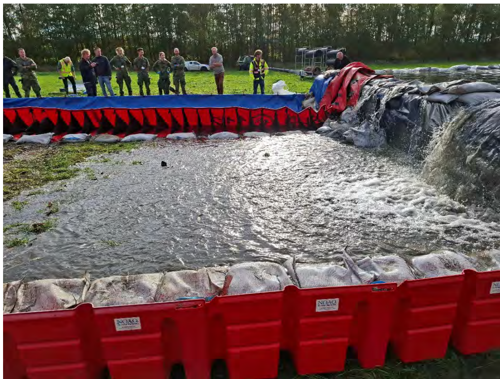
Figuur D.40 Vullen van het testbassin. In deze testconfiguratie wordt het bassin tussen de block-bag-wanden door drie verschillende systemen afgedamd. Op de voorgrond een rij Waterschotten, geballast met zandzakken, in de achtergrond de GeoDesign Barrier. Daartussen de Buitink Flexibele Waterdam. Het Buitink-systeem is over de wand heen getrokken waarbij een hoek van 90° ontstaat en het zeil vouwen vormt. De hierdoor verzwakte aansluiting is met behulp van zandzakken afgedicht. Het Buitink-systeem is met steuntjes in een opgeklapte positie gebracht. Voor een goede aansluiting met de ondergrond is het horizontale gedeelte van het zeil met zandzakken geballast.
