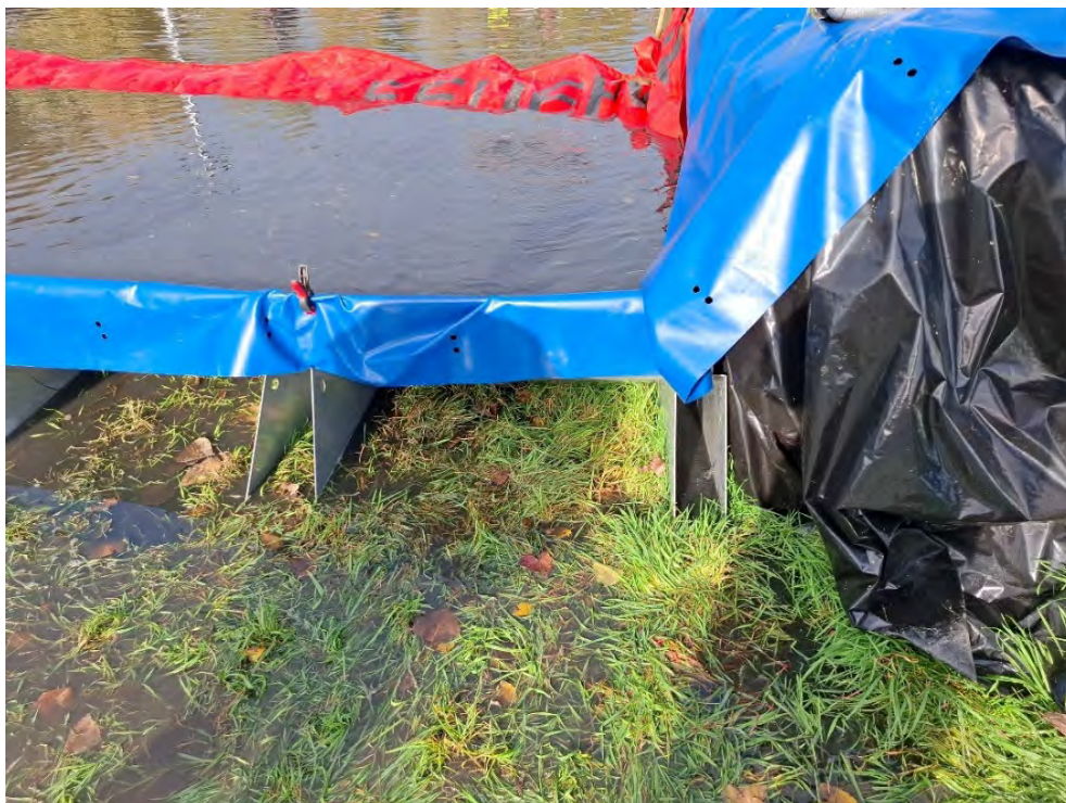
Figuur D.45 Toegenomen geaccumuleerd nemend lekwater.
