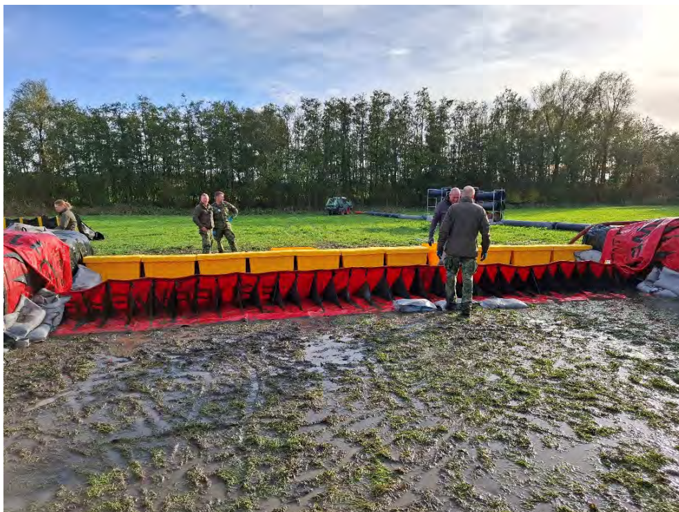
Figuur D.81 In deze testopstelling wordt de BoxBarrier achter een Buitink Flexibele Waterdam geplaatst.
