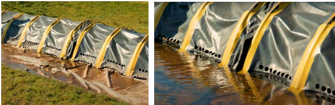
Figuur C 85 Zicht op het schort en de waterzijde van de TubeBarrier waar zich openingen bevinden, waar het water gaat instromen om de TubeBarrier door het gewicht van het water stabiliteit te geven.
