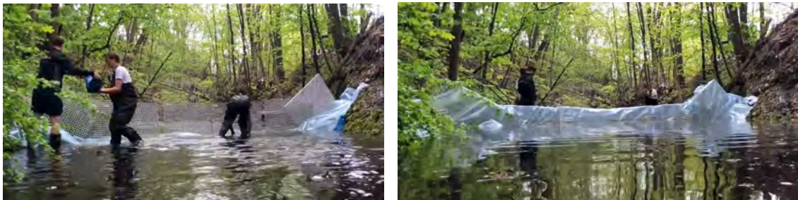
Figuur A.6 Aanleg van een Haawal-barrière in een beek om deze af te dammen.
