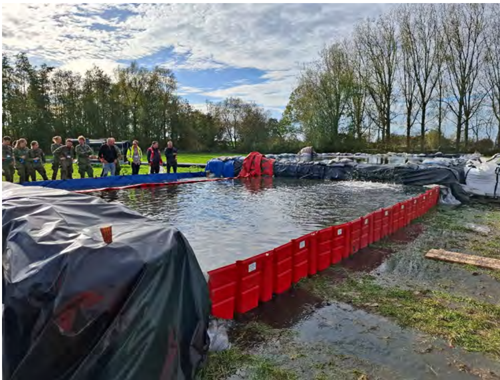
Figuur 5.1 Impressie van de oefening Wolkbreuk. Bij de hier weergegeven testopstelling zijn de systemen Waterschot, Buitink Flexibele Waterdam en Geodesign Barrier gezamenlijk getest.
