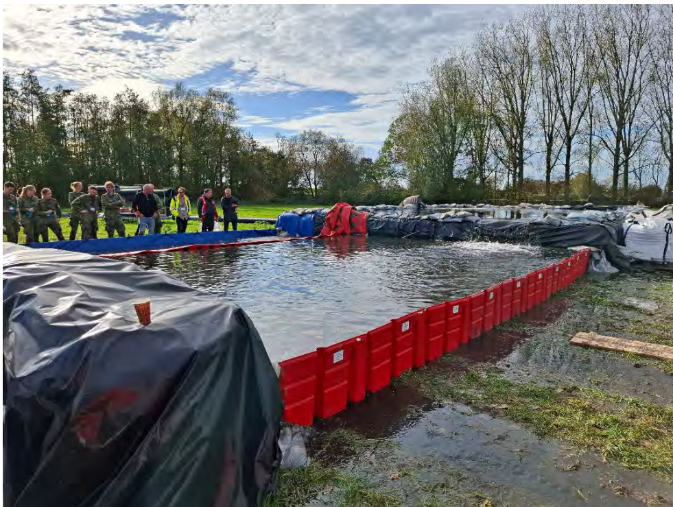
Figuur D.41 Het bassin is circa halfgevolld. De bovenkant van het Buitink-systeem gaat met het stijgende water omhoog tot aan zijn maximale beschermhoogte. Bij de twee andere systemen is nog voldoende marge in de hoogte aanwezig. Men ziet echter al behoorlijke onderloopsheid bij het Waterschotsysteem op deze grasondergrond.
