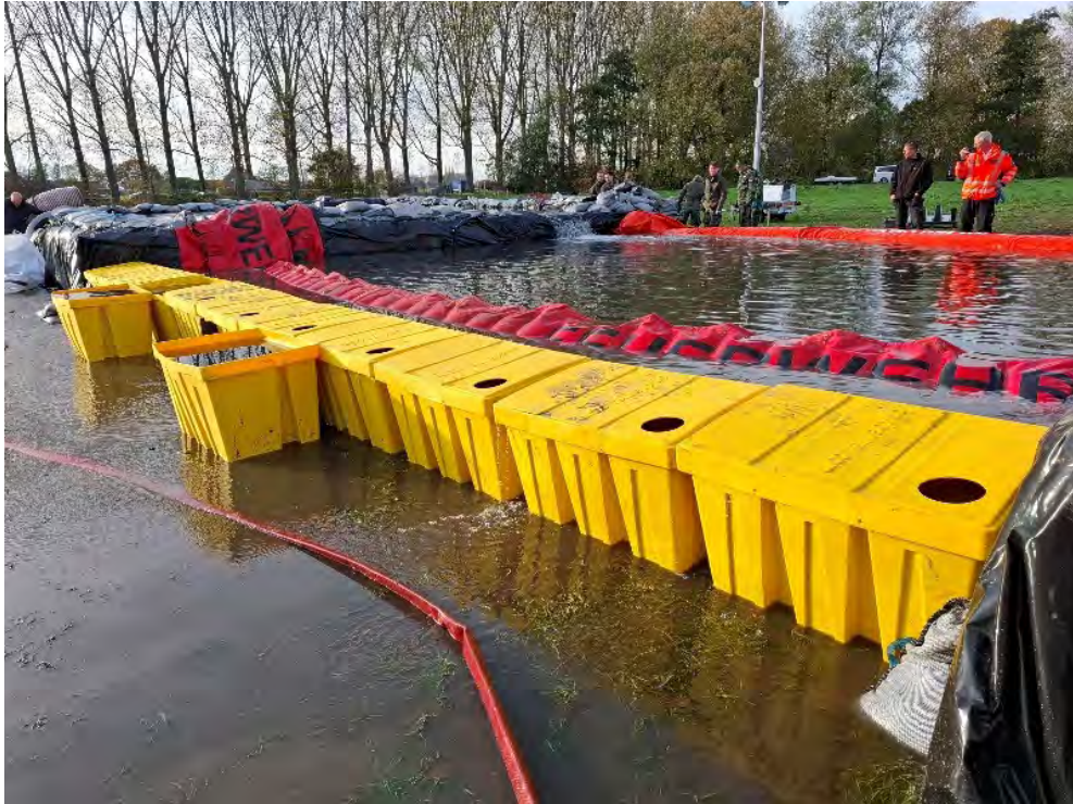
Figuur D.83 Bij een hogere buitenwaterstand gaat de BoxBarrier iets opdrijven en kantelen en treedt er veel vervorming en onderloopsheid op.
