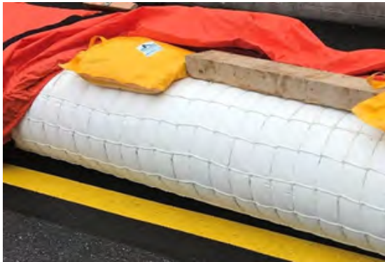
Figuur C 76 Verhogen van het systeem met zandzakken en bielzen.
