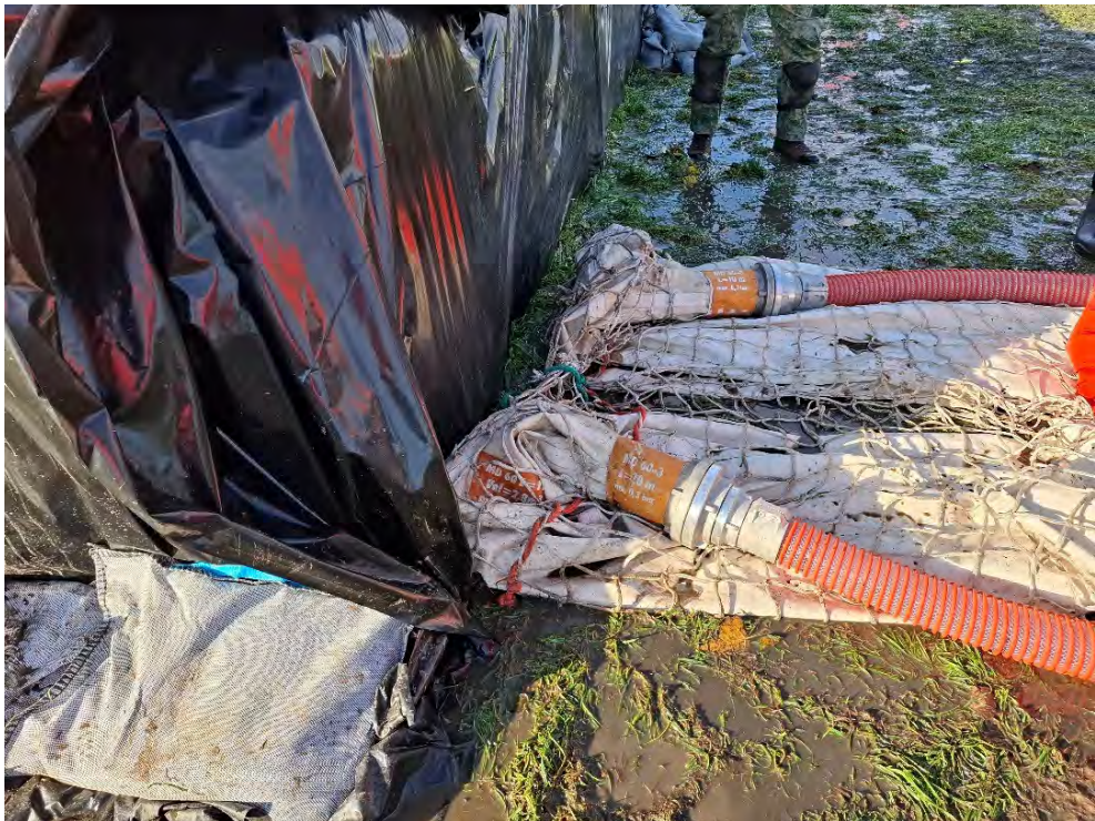
Figuur D.56 Mobildeich met aangesloten slangen tegen het waterreservoir aan geplaatst.
