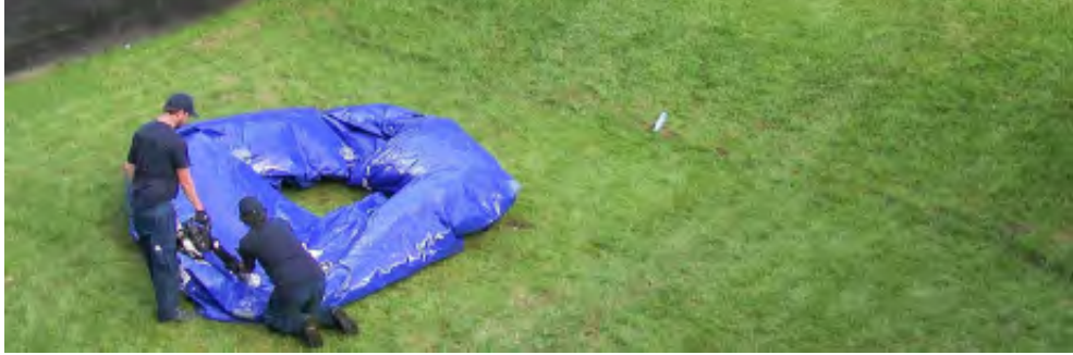
Figuur C 44 Vullen van de Flutschutz-Quellkade met lucht.
