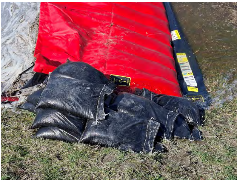
Figuur C 31 Aansluiting van BFT aan een talud met behulp van zandzakken.
