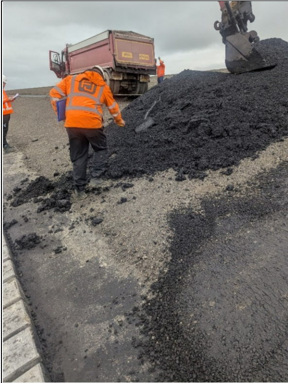
Figuur 1 Lossen van het asfalt uit de vrachtwagen en direct meten van de asfalttemperatuur
