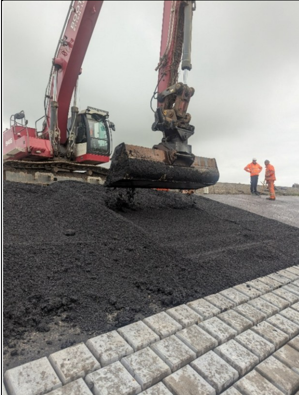
Figuur 3 Aanbrengen van het asfalt in het vak met de bak van de kraan
