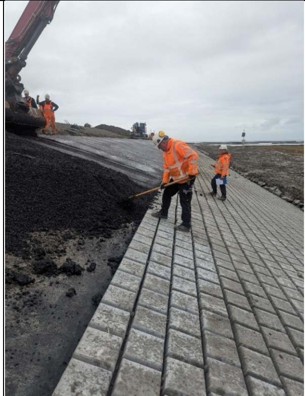
Figuur 4 Het op hoogte brengen van het asfalt met de hark
