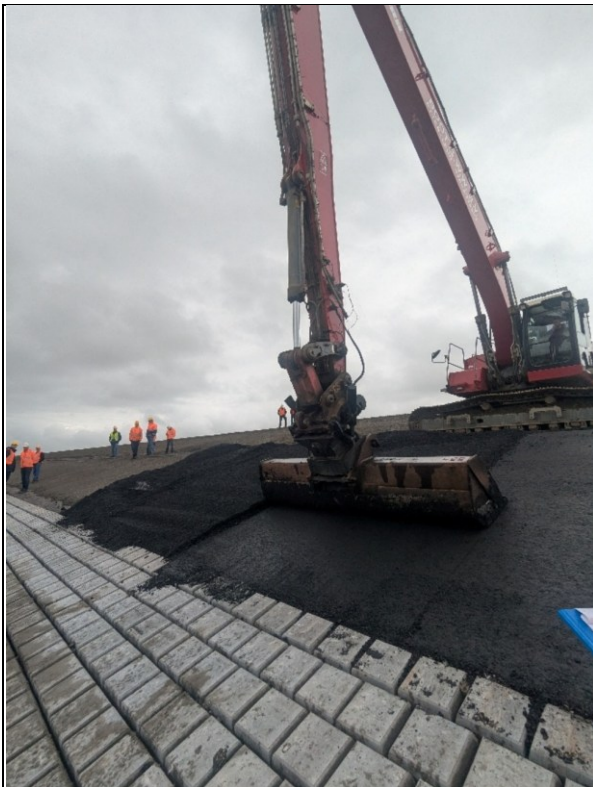
Figuur 5 Profileren van het asfalt
