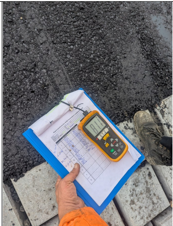
Figuur 6 Temperatuurmeting direct na het profileren
