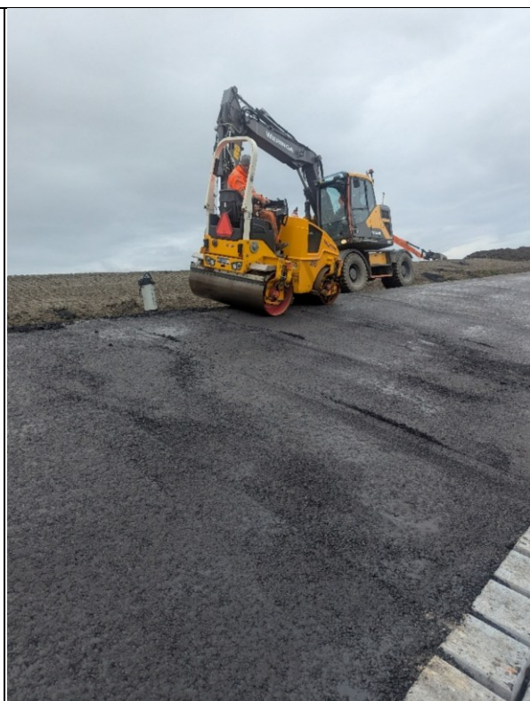
Figuur 10 Walsen van de overgang met de berm
