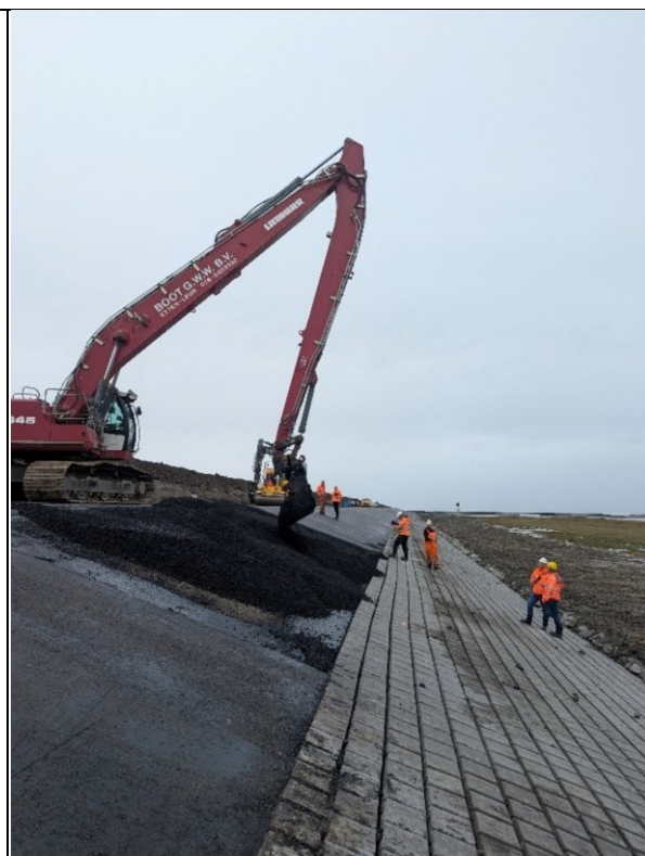
Figuur 14 Aanbrengen van het laatste deel van het proefvak
