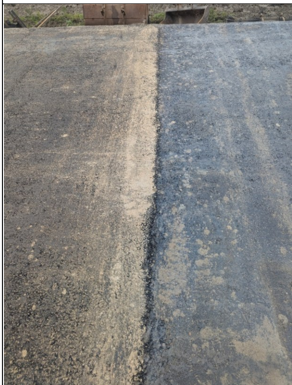
Figuur 15 Aansluiting op het volgende vak (daglas)
