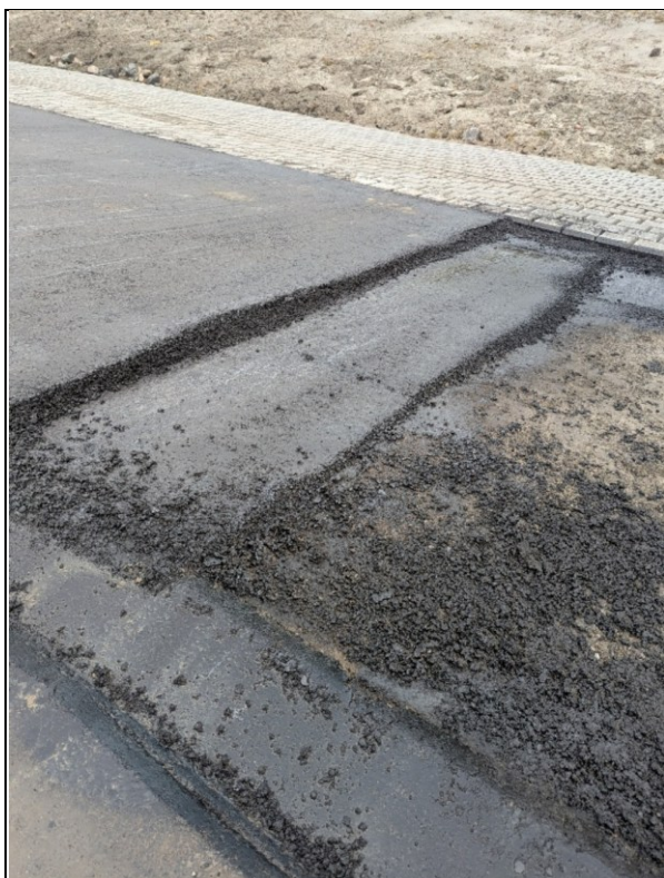
Figuur 13 Daglas aan het einde van het proefvak
